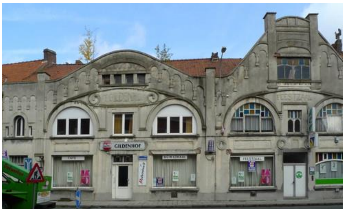
Figuur 11: Zicht op het gebouwenbestand voor de afbraak. (bron: Het Volksbelang | Inventaris Onroerend Erfgoed )
