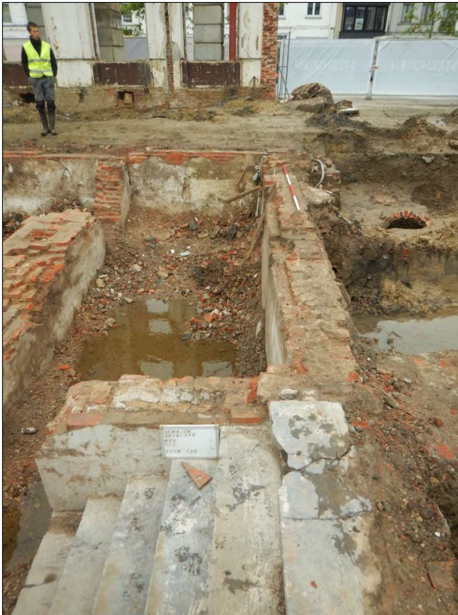
Figuur 53: S118, fundering van de zuidelijke gevelmuur. Rechts op de foto is een bakstenen water/bezinkput te zien.
