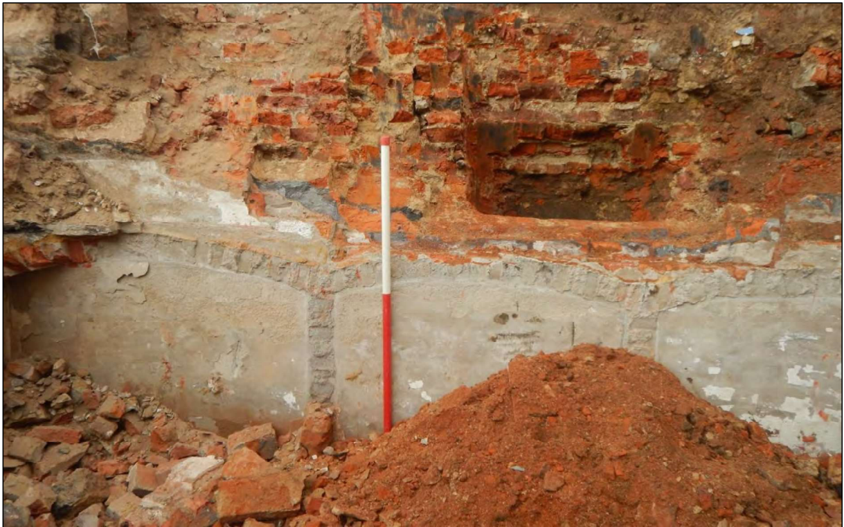
Figuur 55: Zicht op de aanzet van het plafond met aangemetsste bogen en de afdruk van de onderverdeling in de noordelijke kelder.
