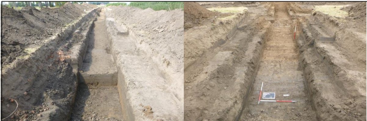
Figuur 10: Overzicht: Links WP1 vanuit zuiden genomen en rechts: WP2 vanuit oosten genomen (ABO nv)
