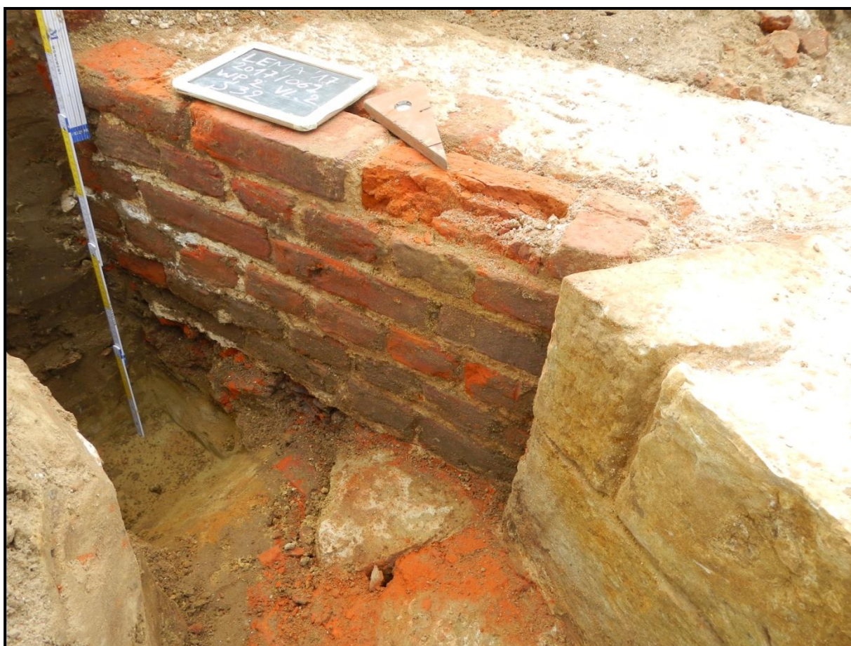
Figuur 18: Detail op de overgang van de rijen bakstenen en de recht gekapte (Lediaanse) natuurstenen van de kerkhofmuur uit de 16 de – 17 de eeuw.
