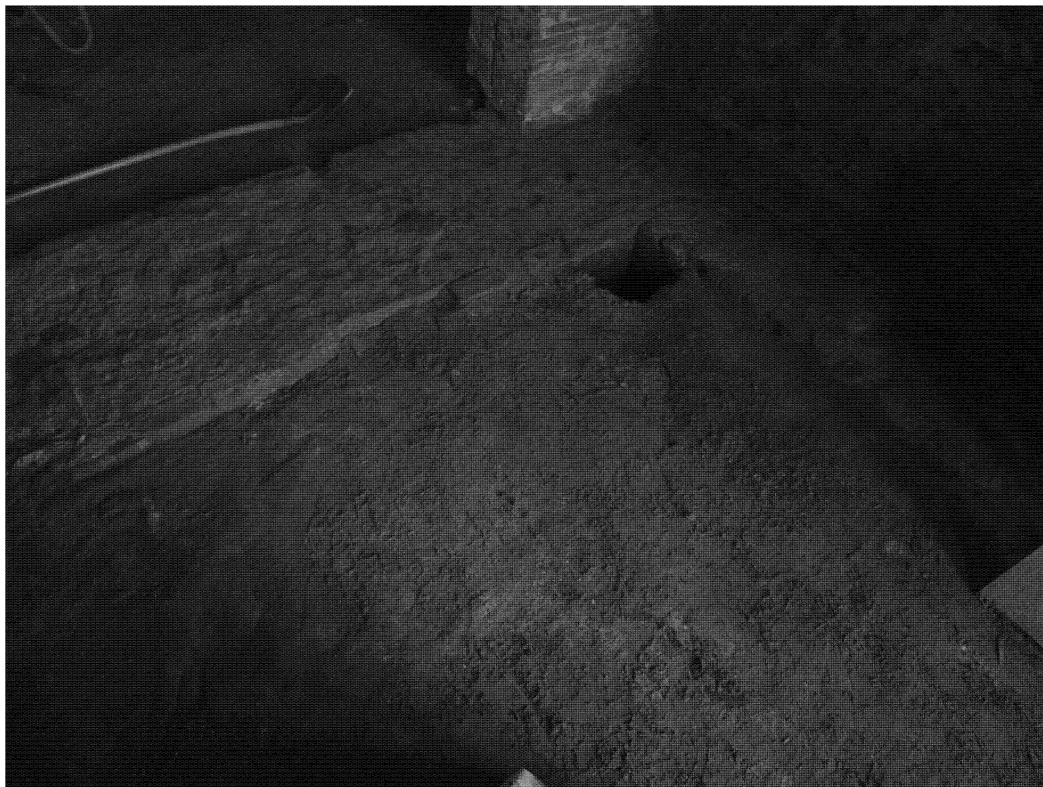
Fig. 4 De bakstenen fundering. Foto genomen in zuidwestelijke richting.
