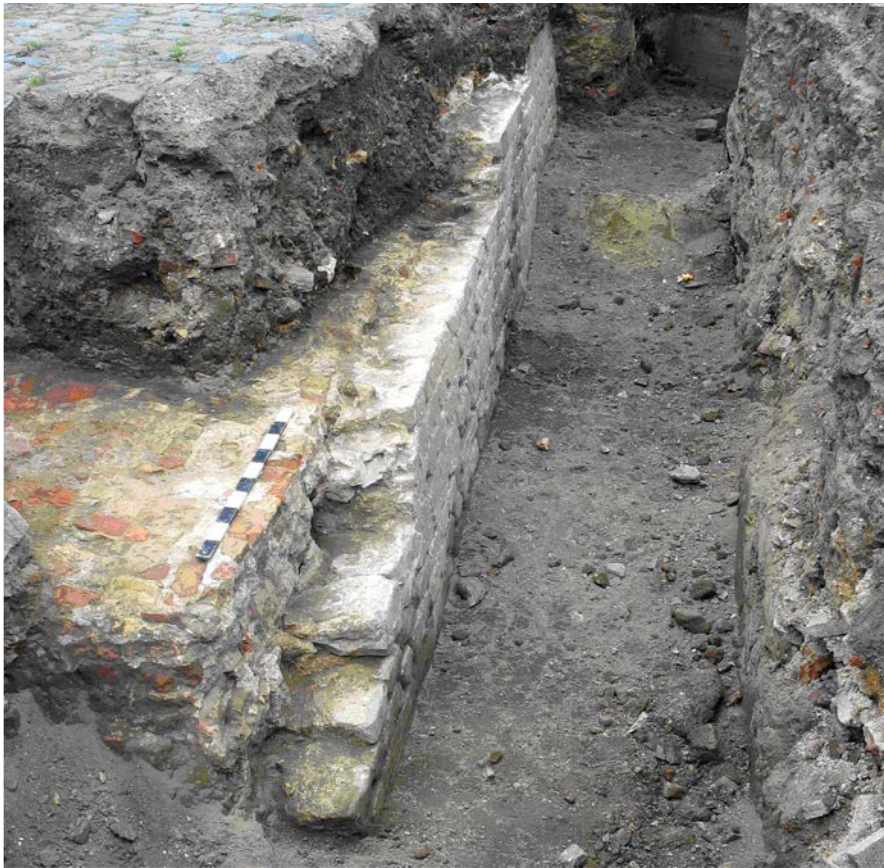
Figuur 33. Muurkern en parement van de stadsomwalling
