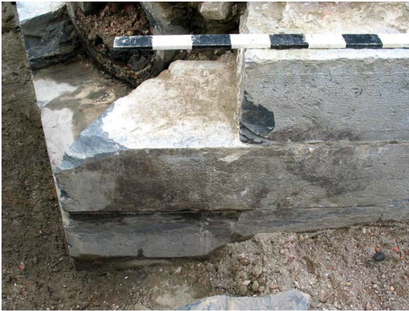
Figuur 23. Detailopname van de bastionflank
