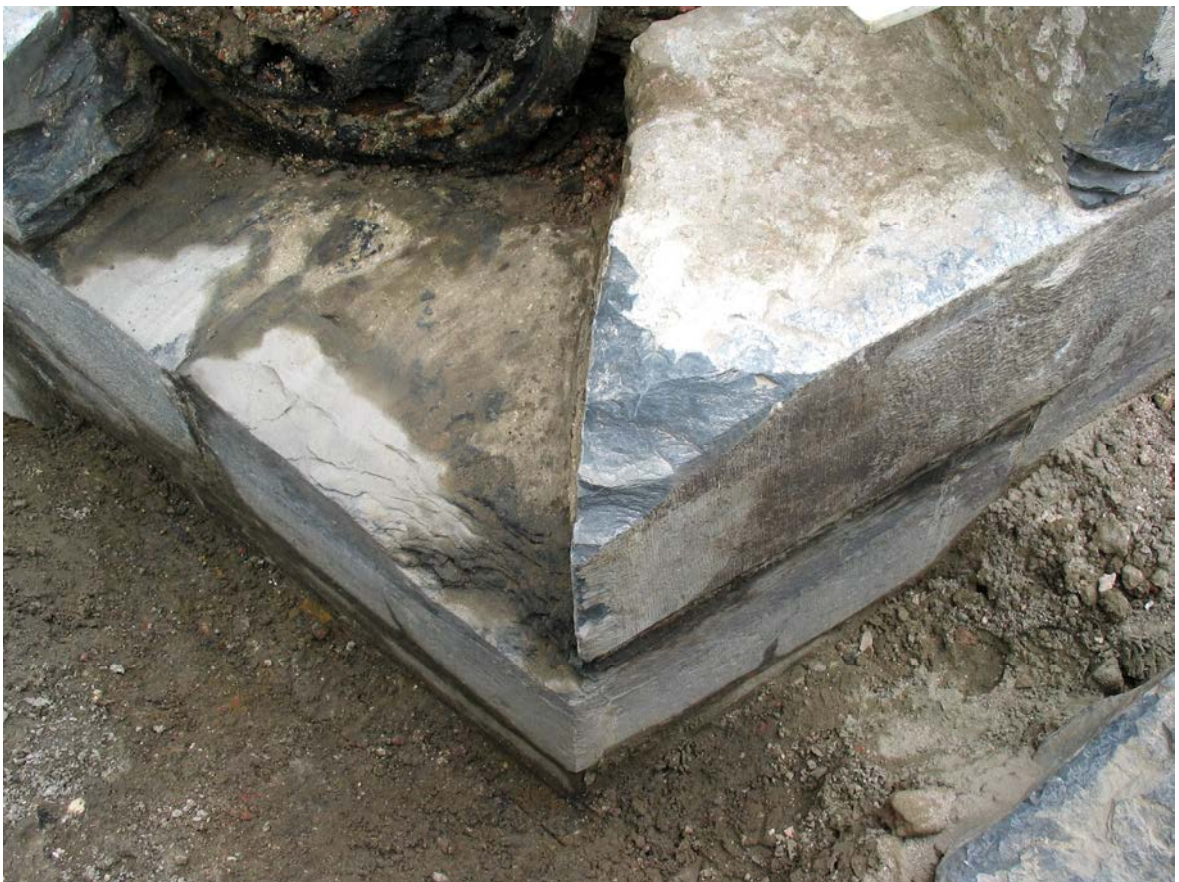
Figuur 24. Detailopname van de zuidelijke bastionhoek
