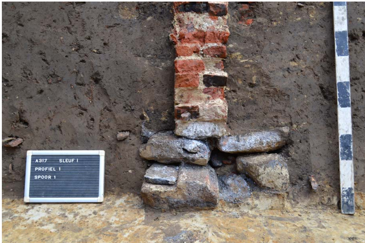
Figuur 8. Sleuf I, profiel 1, muur S1: natuurstenen onderfundering
