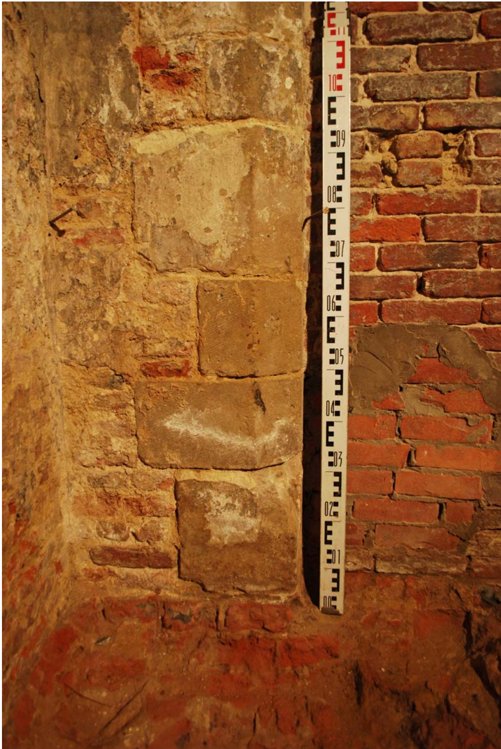
Figuur 4. Detail van de gewelfpijler in Ledesteen in de noordoostelijke kelderhoek: bakstenen metselwerk uit de tweede helft van de 15 de eeuw (links in beeld); gesegmenteerde, natuurstenen pijler met biljoen en onderaan kapel, scharreersporen van ceseelgebruik, idem datering (midden); postmiddeleeuwse en/of moderne bakstenen muur als opvulling en scheiding onderin de segmentboog (rechts).
