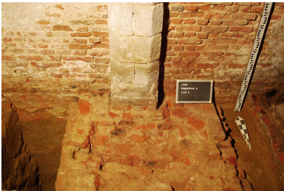
Figuur 10. Zicht op de laatmiddeleeuwse gewelfpijler in muur S3 (boven) en de massieve steenstructuur S1 (onder midden).
