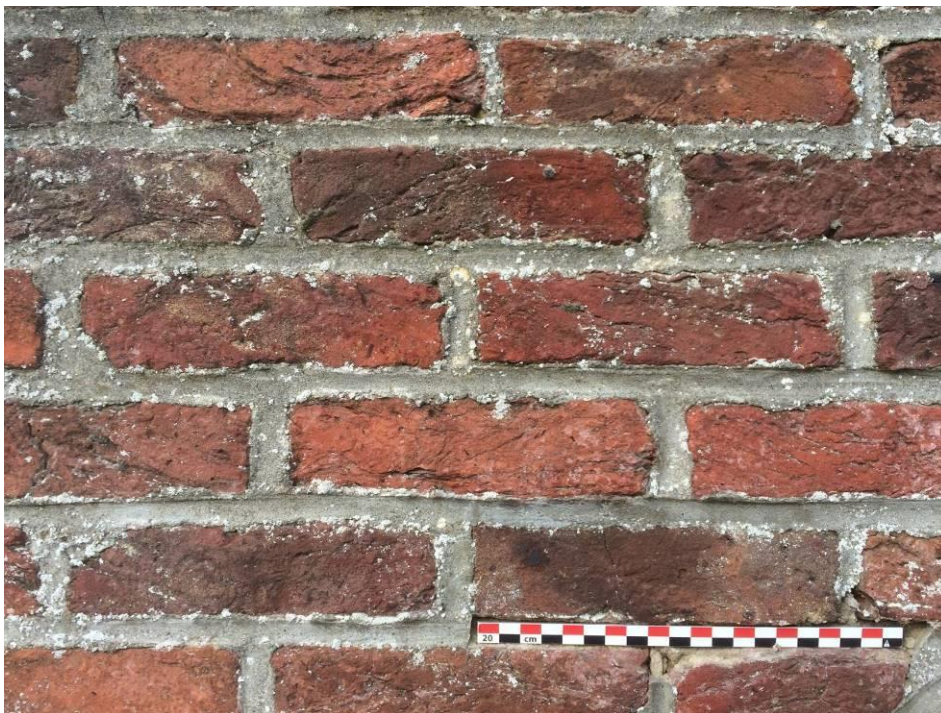
Figuur 121. Baksteenmetselwerk van de voorgevel van de Kruisborrekapel. (Foto Walter Sevenants 08/03/2019)
