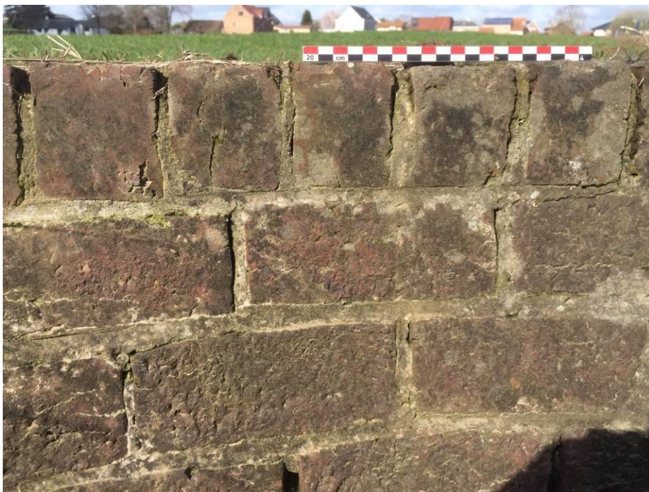
Figuur 123. Baksteenmetselwerk van de keermuur achter de Kruisborrekapel. (Foto Walter Sevenants 08/03/2019)
