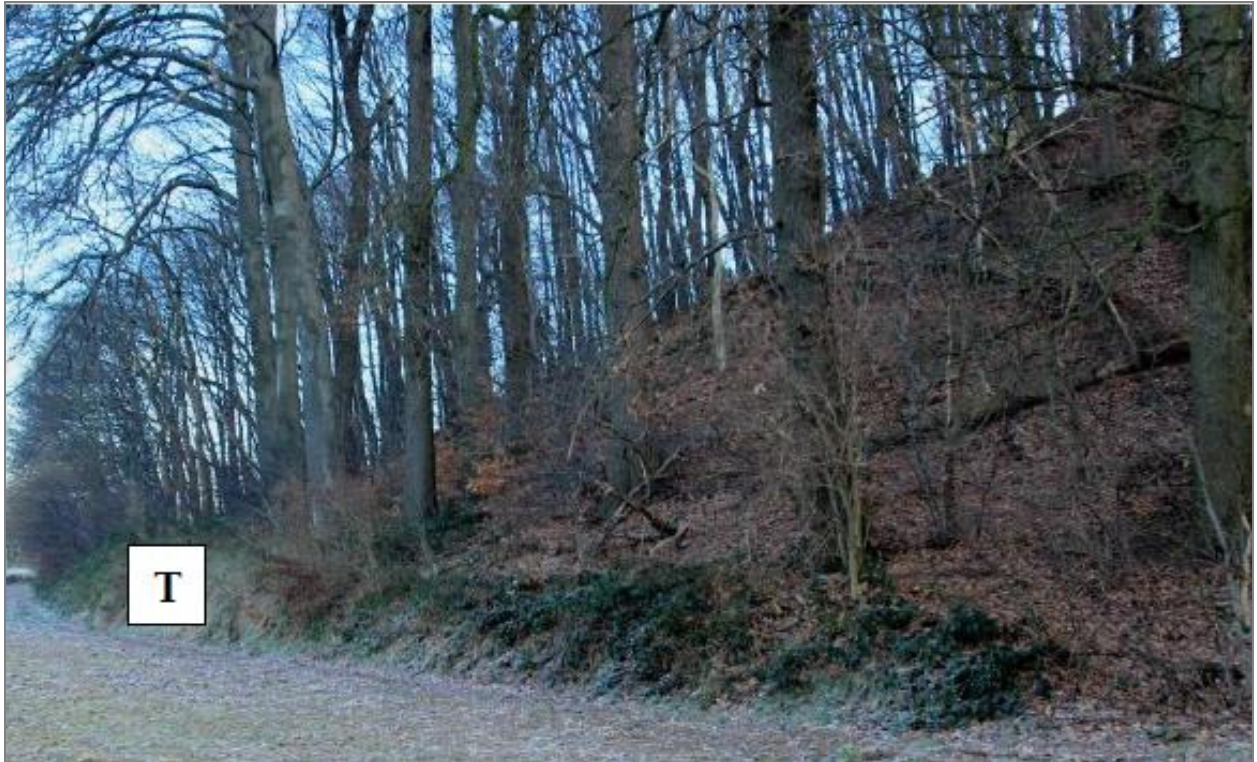
Figuur 44. Het talud aan de noordwestelijke zijde van de heuvel langs AOZ04. (Foto Roger Langohr, 2013).
