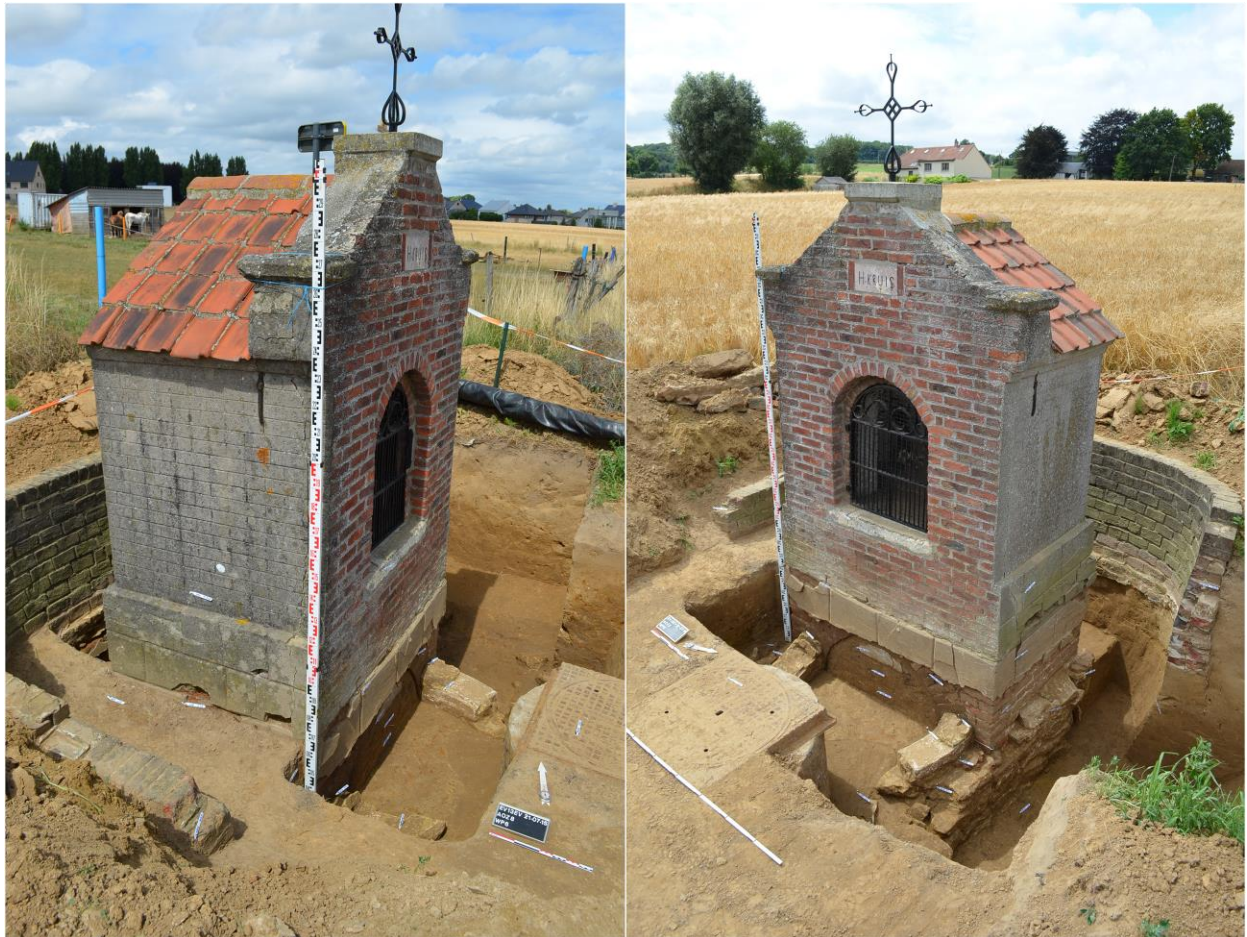
Figuur 124. Aanleg van werkput WP6 rond de Kruisborrekapel. (Foto Walter Sevenants 19/07/2015)
