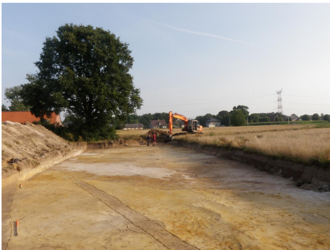
Afbeelding 10: Sfeerfoto tijdens de aanleg van de westelijke helft van werkput 3.
