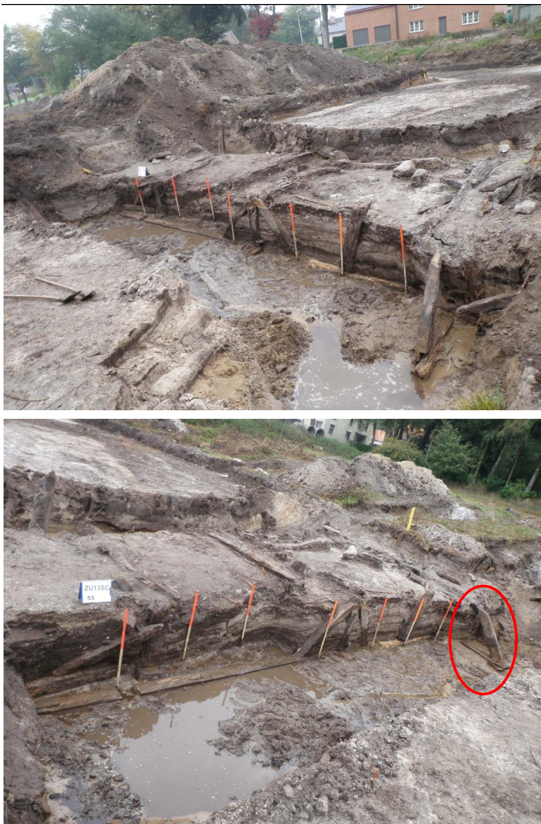
Afbeelding 36: Brug Profiel 1 kijkende vanuit het zuiden.
