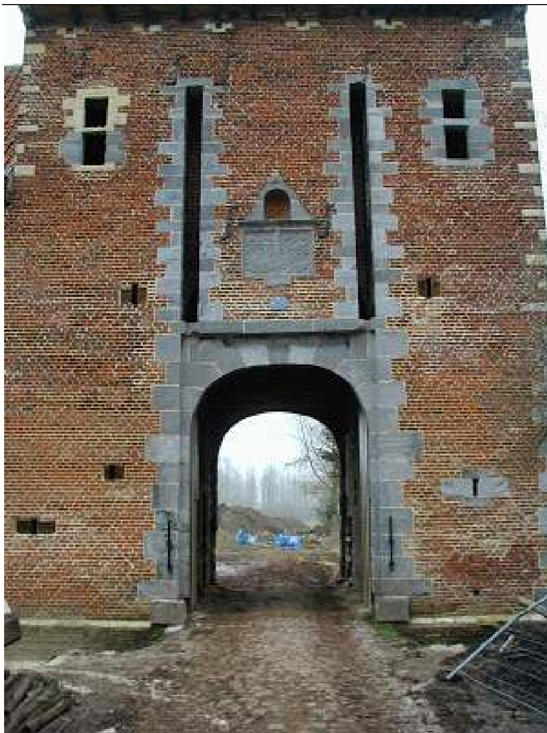
Afbeelding 45: Twee verticale sleuven voor de takels in de kasteelhoeve van Hoen te Geetbets.
