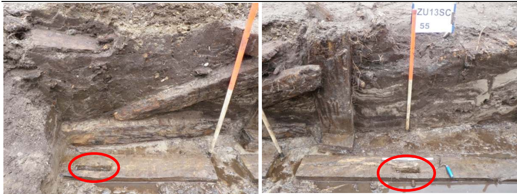
Afbeelding 39: Detailopname van pen-gatverbindingen in de funderingsligger.
