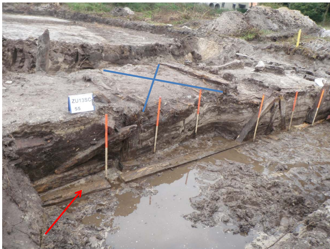
Afbeelding 38: Detailopname van de funderingsligger.
