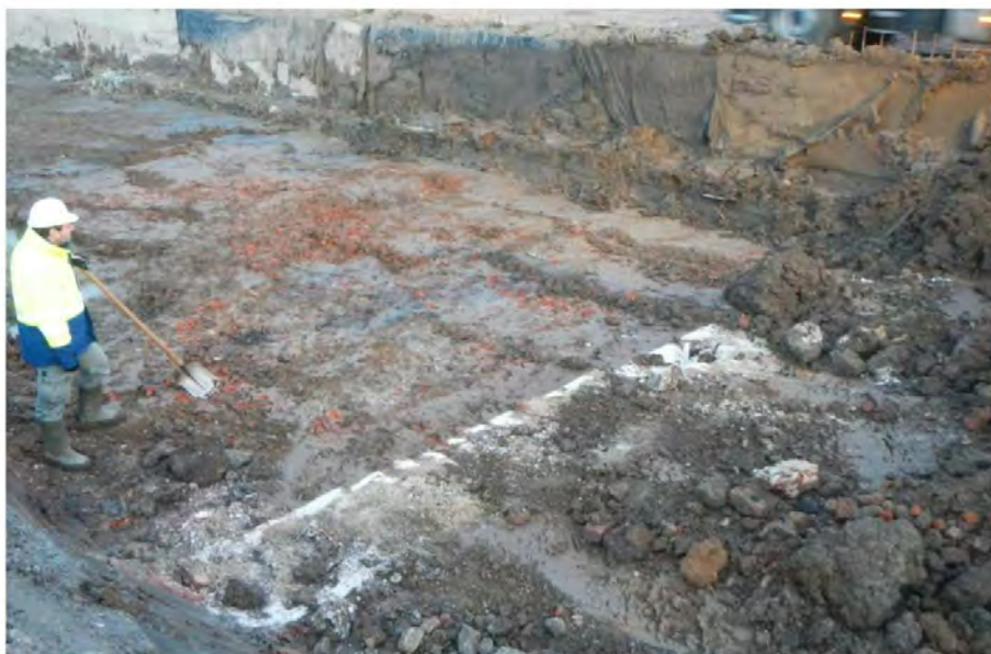
Figuur 77. De muur in kalkzandsteen.
