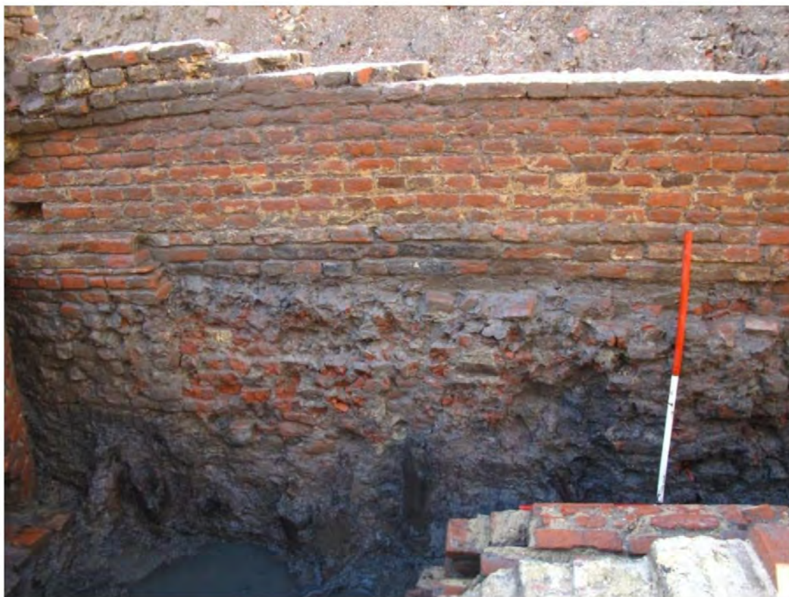
Figuur 49. Fundering van Gebouw III.
