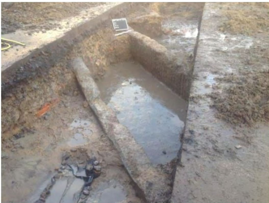
Figuur 28. Noordelijk toegangsgedeelte van de publieke schuilbunker.
