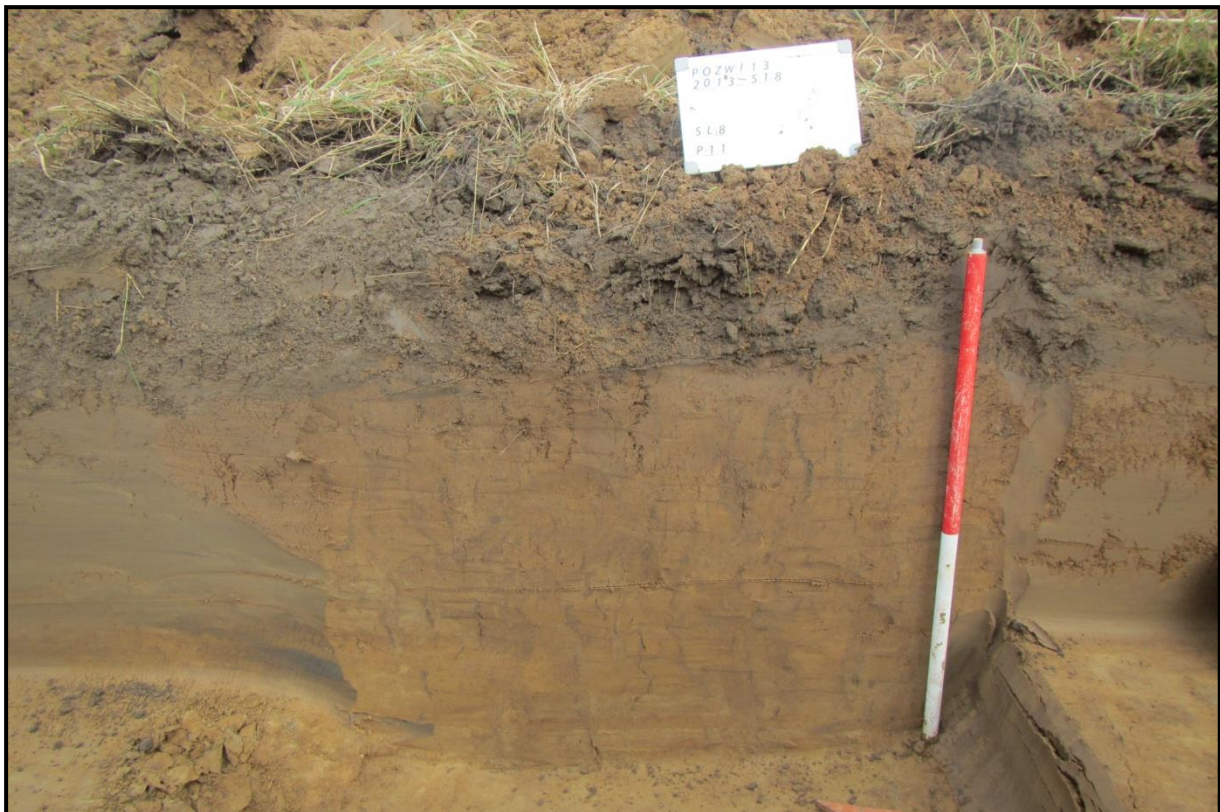
Figuur 23: Profiel 11 in sleuf 8.
