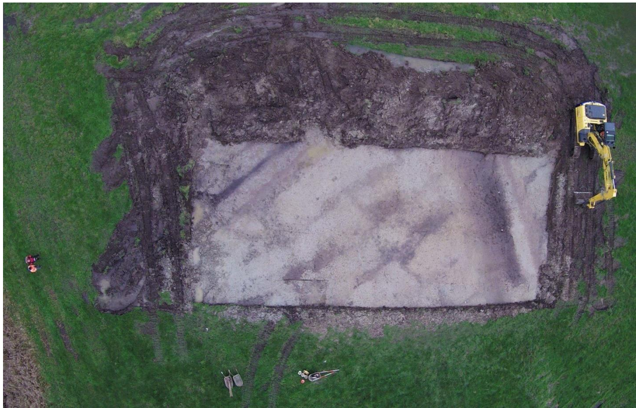
Figuur 53: Drone-opname van sleuf 2
