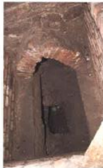
Zicht op de opengebroken kanalisaties (7) op de benedenverdieping
