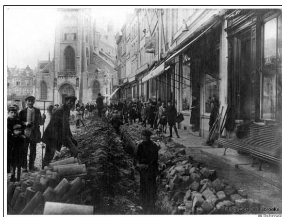
Figuur 23 Verschillende foto's van de werkzaamheden. (verz. W. Ilsbroekx)
