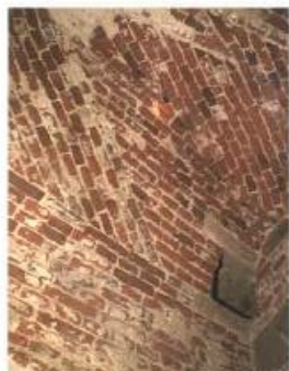
Baksteen gewelf met vlechtingen boven schietkamer (20) met rookkanaal
