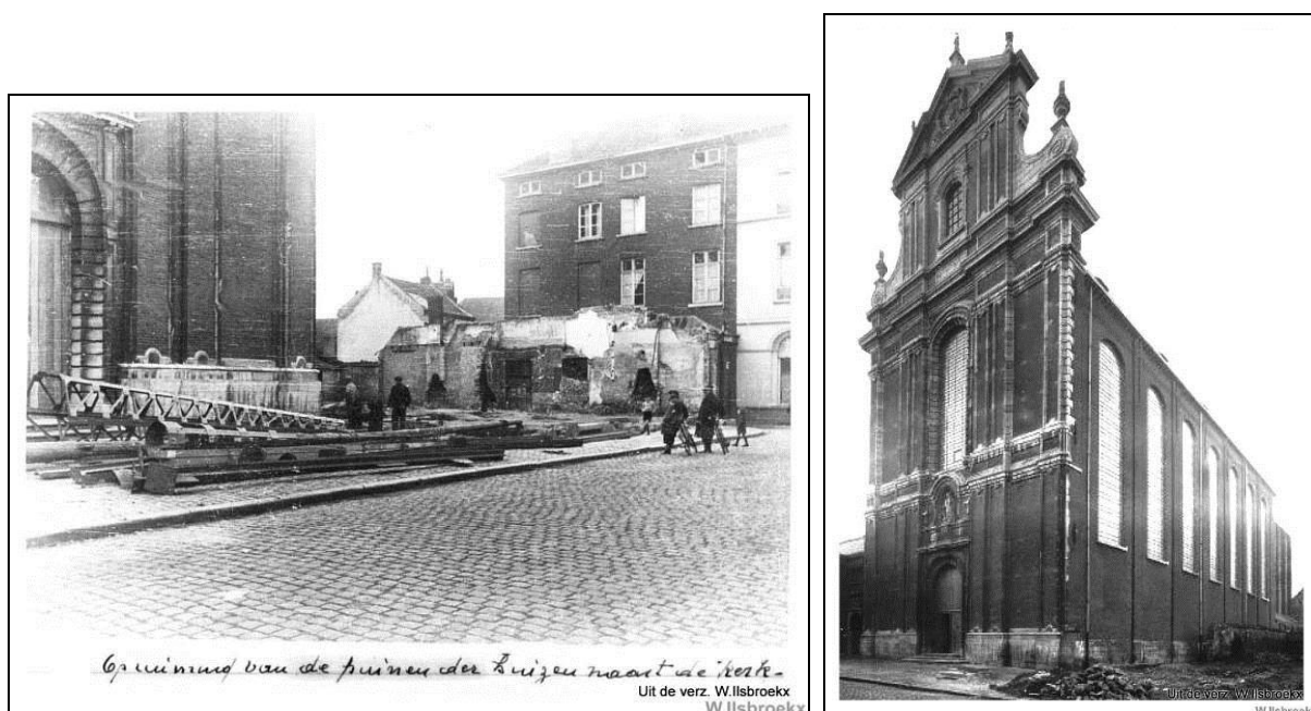
Figuur 50 Zicht vanuit de Minderbroedersstraat na het opruimen na het bombardement. (verz. W. Ilsbroekx)
