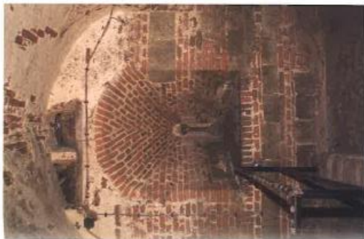
Bovenverdieping met van links naar rechts: kanongat (34), de 'schouwpijp', waarin de rookkanalen van de benedenverdieping naar boven lopen (33), kanongat (32)
