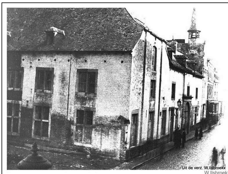
Figuur 67 Foto waarop het hoekhuis afgebroken is, zicht richting Sint-Augustinuskapel. (verz. W. Ilsbroeckx)
