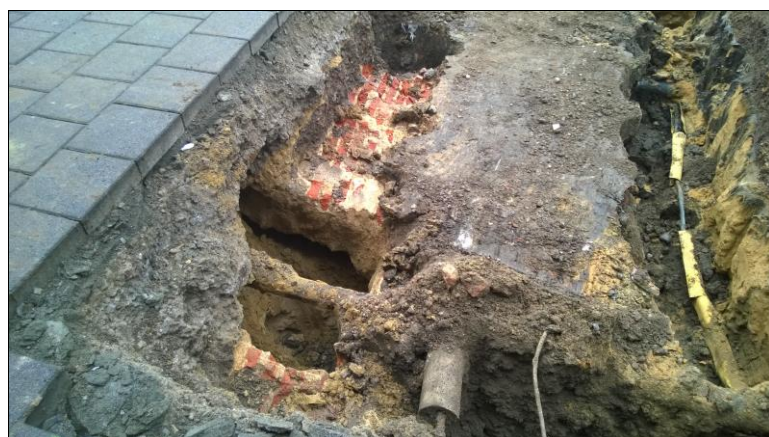
Figuur 36: Foto's van twee van de kelders die tijdens de werfbezoeken werden beschreven. (Stad Sint-Truiden)
