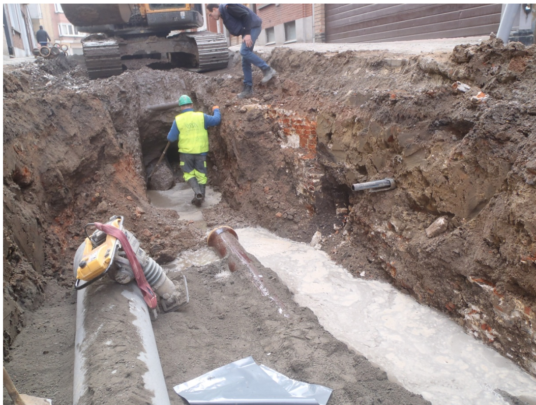
Afb. 4. Het vrijgraven van de oude riolering op de achtergrond. Op de voorgrond is de nieuwe riolering met stabilisatie zand al geplaatst.
