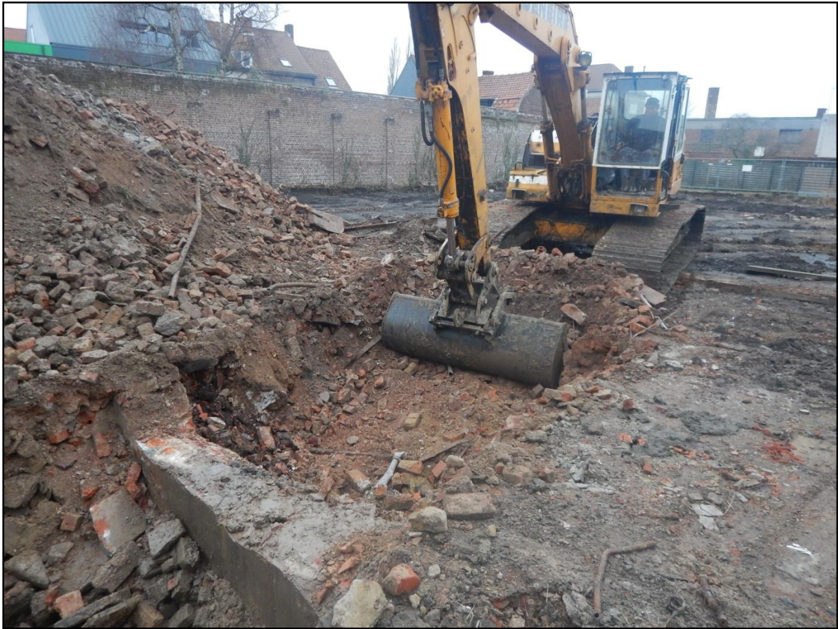
Figuur 36: uitgraven van één van de kelders in sleuf 1.
