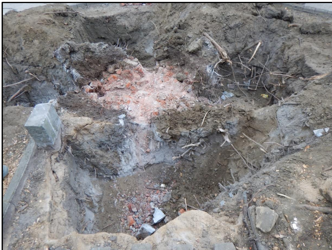
Figuur 284: Bakstenenbasis onder het monument.
