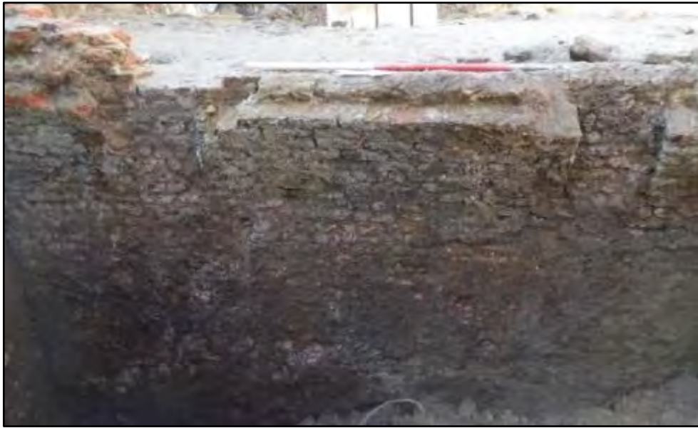
Figuur 61: Balkuitsparingen aan de westelijke zijde (ABO nv 2018)
