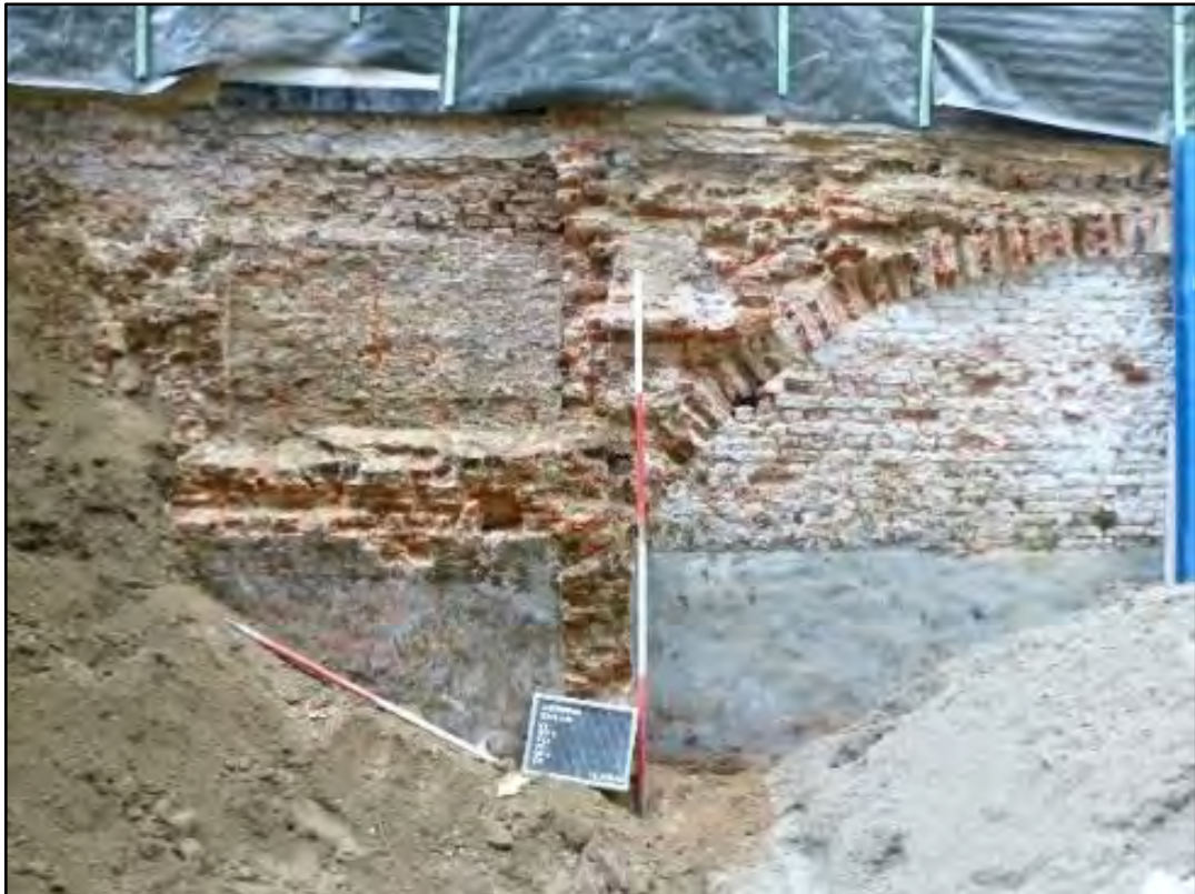
Figuur 27: S1.3 (boog van westelijk gewelfde kelder) (ABO nv 2018)
