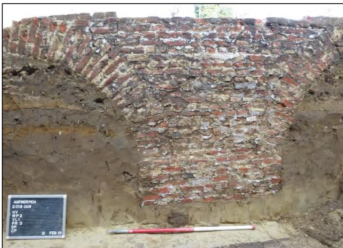
Figuur 83: Profiel 2.3 met detail van een funderingspijler van muur S2.20 (ABO nv 2018)
