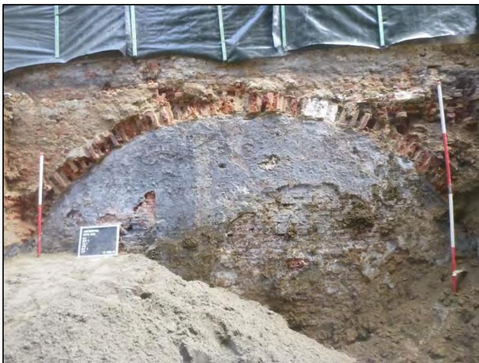
Figuur 24: S1.1 (opgevulde noordelijk tongewelfdeel uitmakend van westelijke kelder) (ABO nv, 2018)
