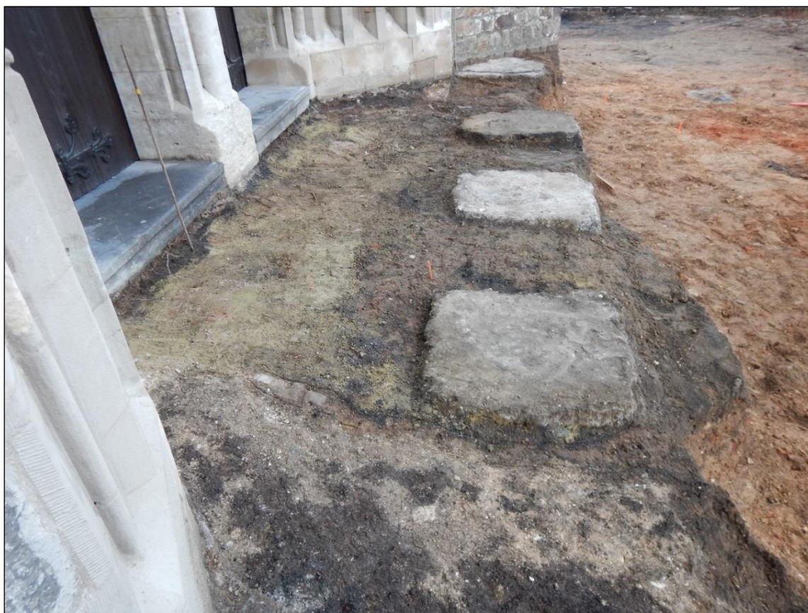
Figuur 213: Zicht vanuit het noorden op de betonnen sokkels voor de kerk.
