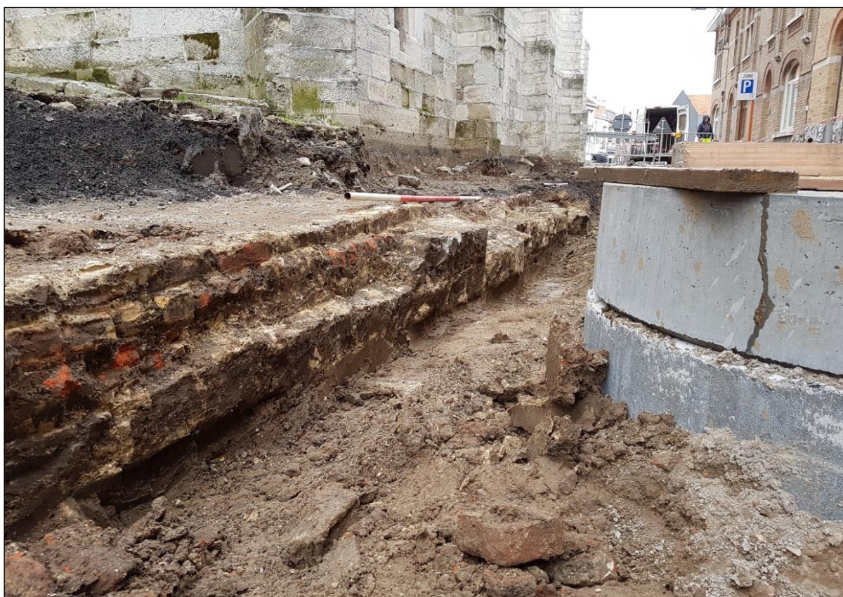
Figuur 192: Zicht op het verloop van de muur vanuit het zuidwesten.
