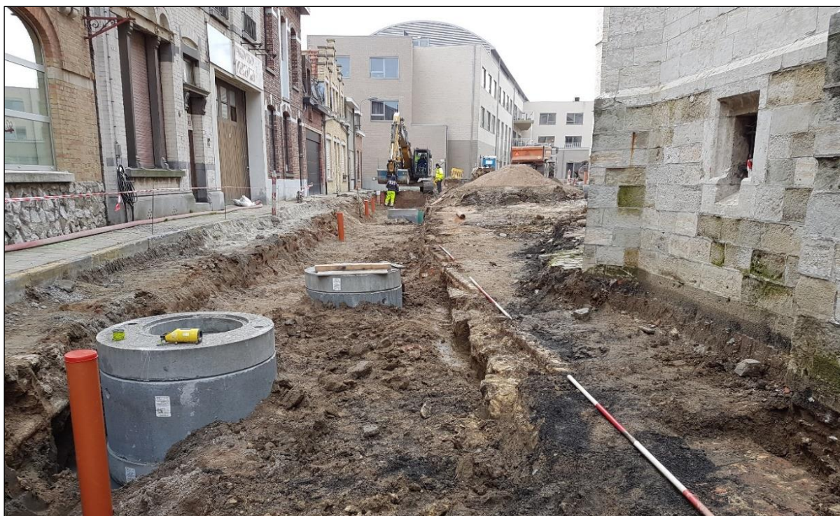
Figuur 191: Zicht op het verloop van de kerkhofmuur naar het zuidwesten.
