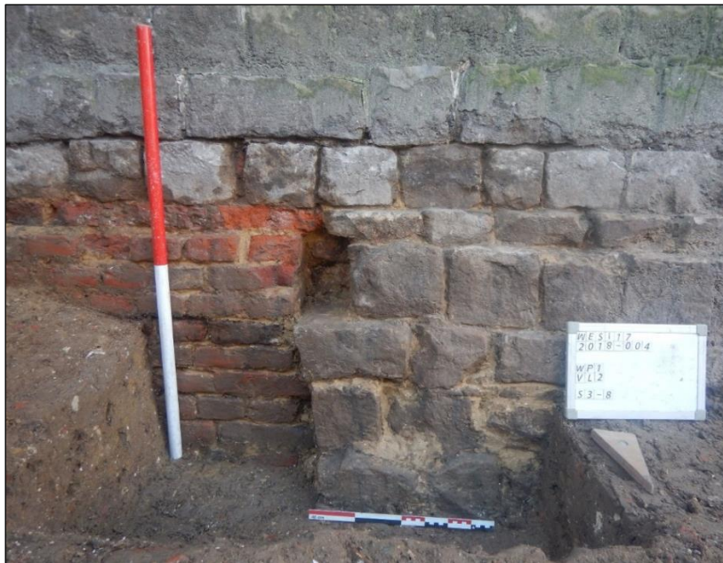
Figuur 180: Overgang tussen bakstenenfundering (S3) en natuurstenenfundering (S8) van de kerk.
