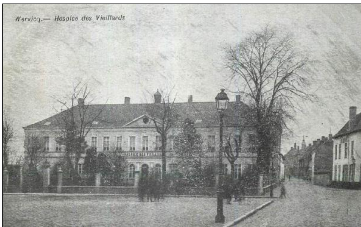
Figuur 49: Het Hospice des Vieillards tijdens de Eerste Wereldoorlog gezien vanuit de Sint-Medardusstraat. De muur met het hekwerk is duidelijk zichtbaar (bron: VERDEGEM & DE GRUYSE 2017).
