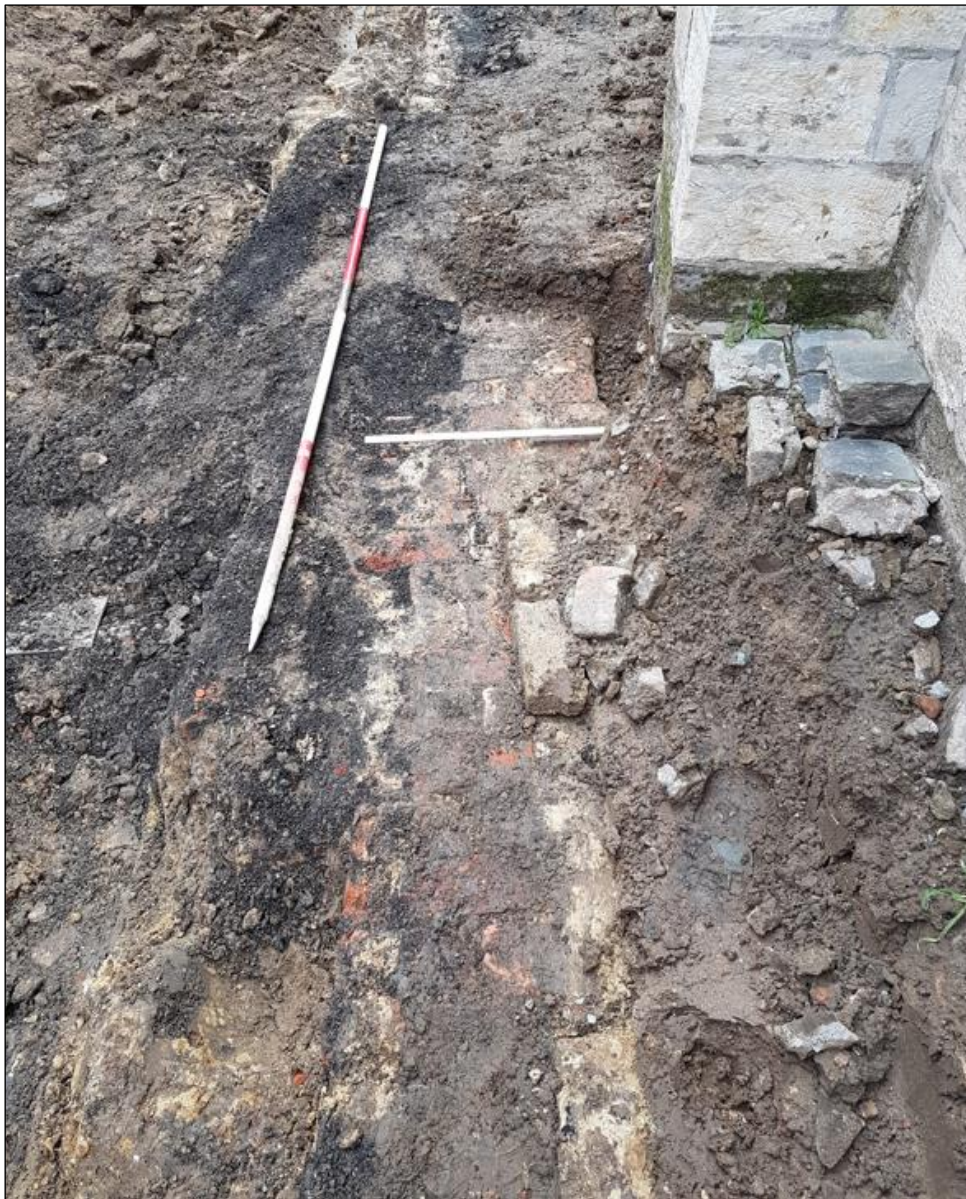
Figuur 190: Zicht op de kerkhofmuur ter hoogte van de kleine steunberen ten zuiden van de kerk.
