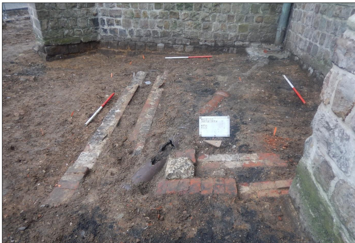
Figuur 208: Drainagesysteem voor regenwater.
