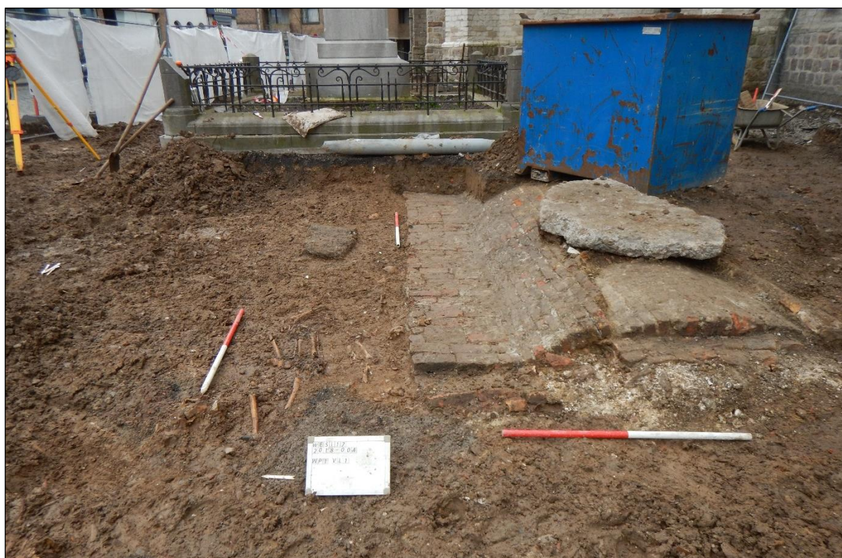
Figuur 209: Waterreservoir. Hier sluit het drainagesysteem op aan.
