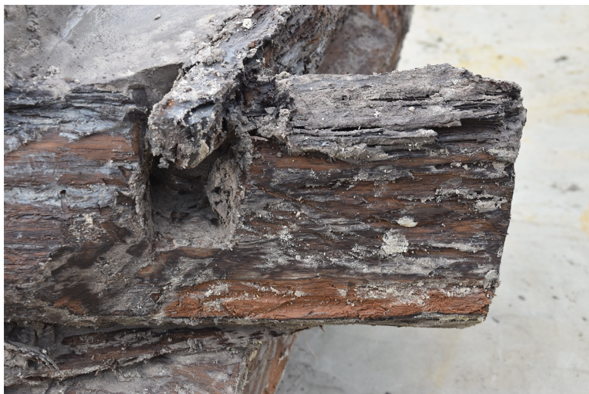
Fig. 3.20: Detail van een zwaluwstaartverbinding.
