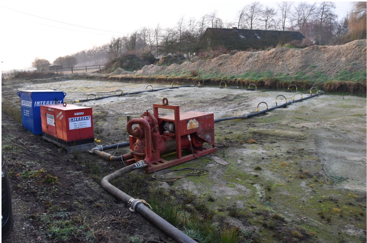
Fig. 2.4: Bronbewatering die rondom de waterput geplaatst is.
