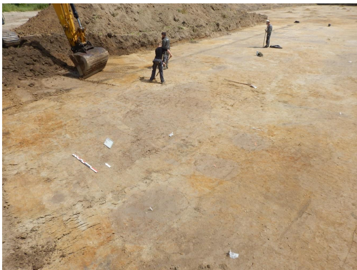
Figuur 44: Grote en kleine ontginningskuilen tijdens de aanleg.
