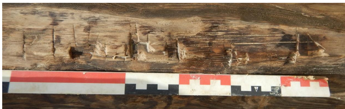
Figuur 37: Detail van inkerving op balk INR 5.
