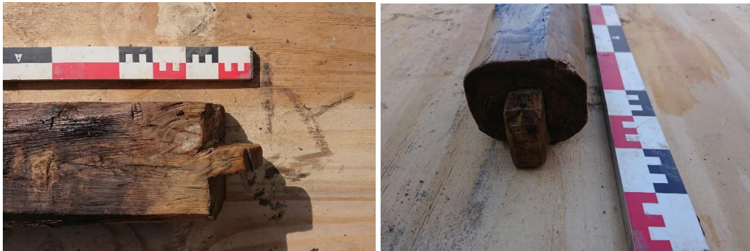
Figuur 39: Detail van het mussenstaartverbindingsstuk van INR 5 (L) en het pengat van INR 8 (R).
