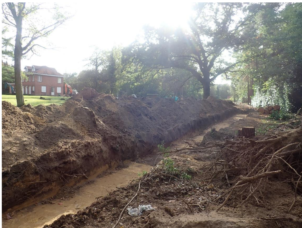
Figuur 6: zicht op het terrein aan de Watermolen (© J. Verrijckt Bvba)
