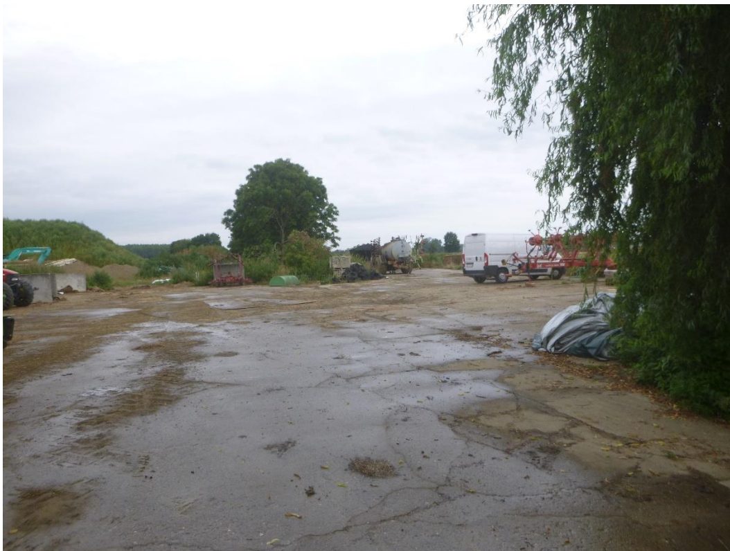
Fig. 1.5. Geetbets – Sanering Hulsbeek (22.531). Overzicht van zone 5. Kijkend in oostelijke richting.
