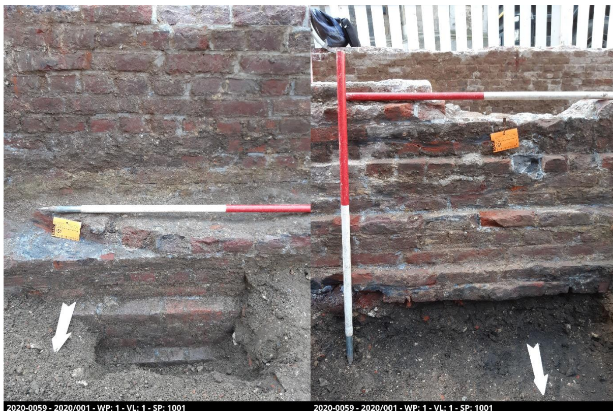
Figuur 13: Foto's van kleinere profielputjes die werden gegraven naast fundering 1001 om de diepte ervan te kunnen vaststellen. Hierop is ook de getrapte opbouw van de structuur duidelijk zichtbaar.
