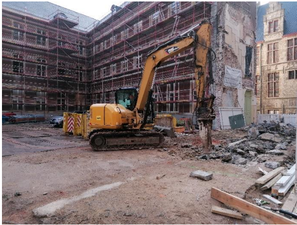
Fase 1: begeleiden van het verwijderen van de vloerplaat
