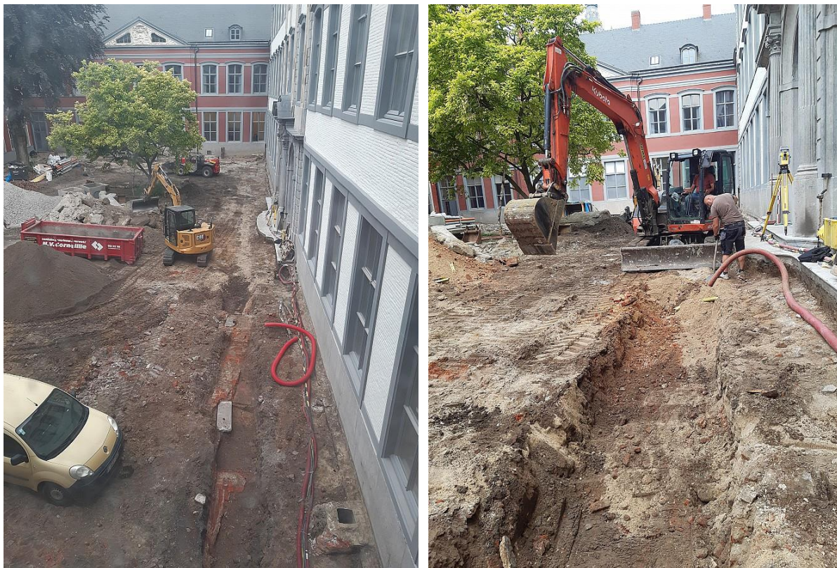
Figuur 25: Uitgraven van de sleuven tbhv nutsleidingen.
