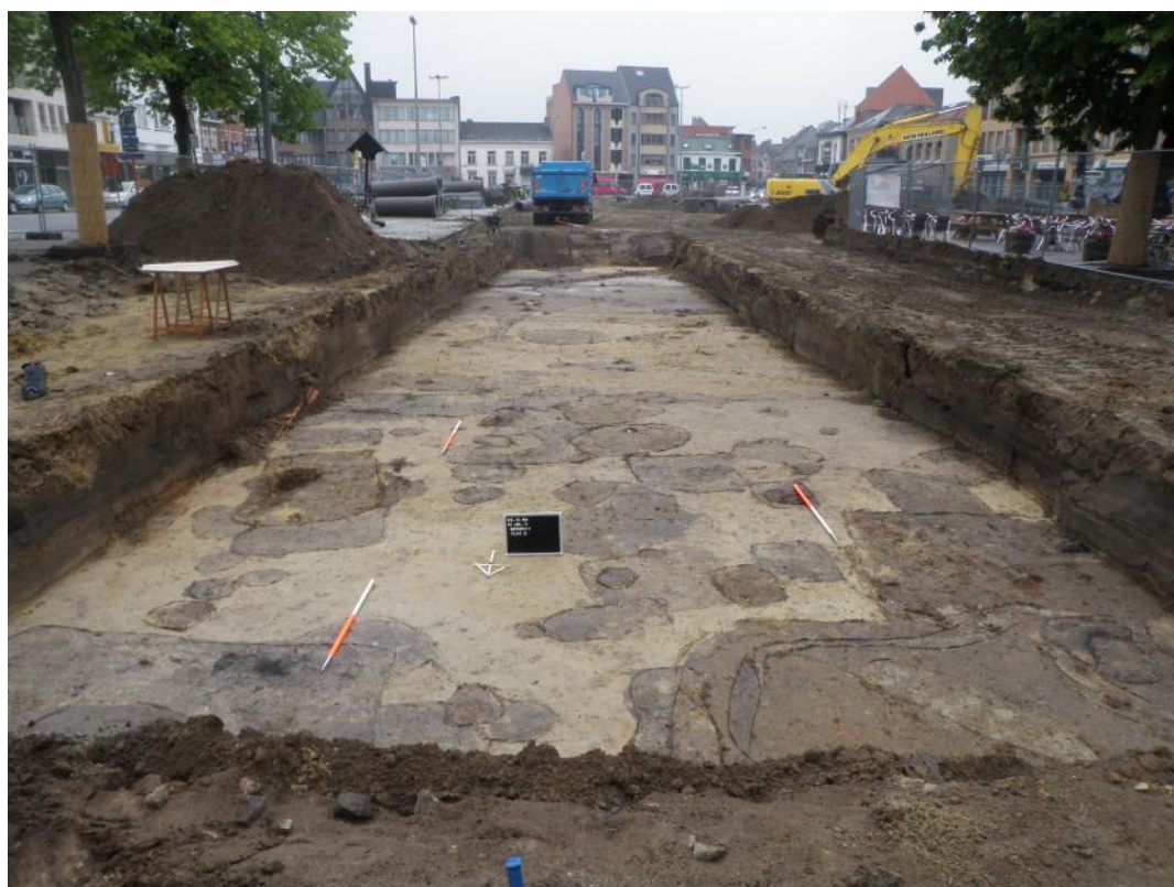
Afbeelding 6.1: Overzichtsfoto van vlak 2 met op de achtergrond de uitvoering van de rioleringswerken.
