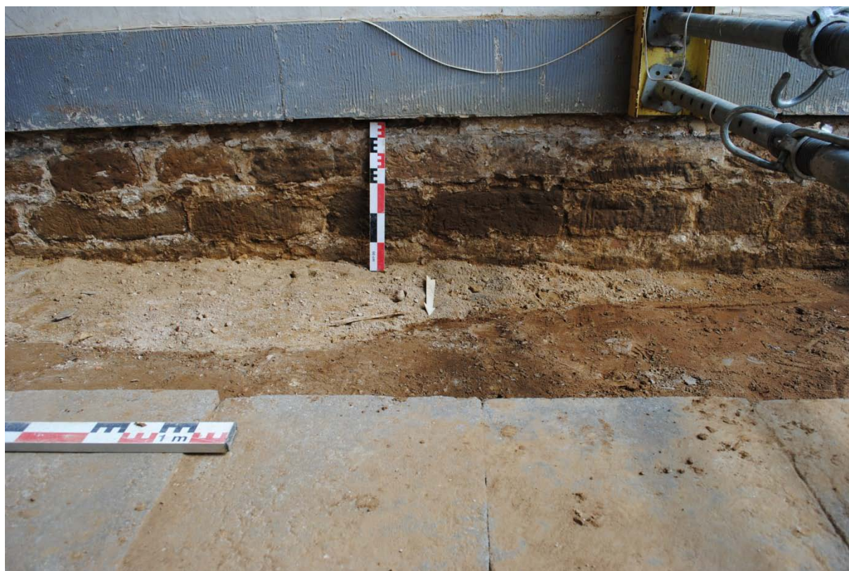
Fig. 4.18: De muur van de zuidelijke zijbeuk (S 109), opgetrokken uit ijzerzandsteen.
