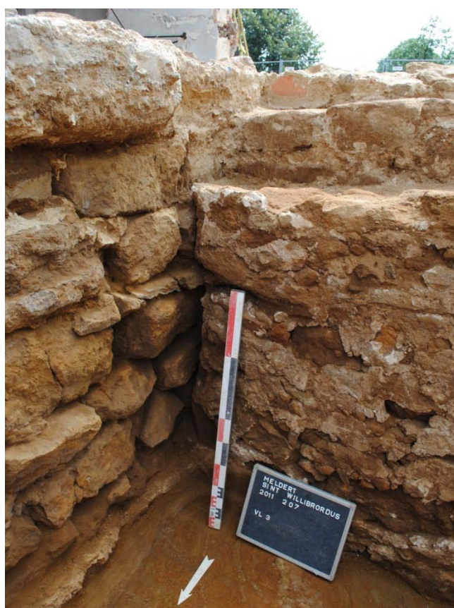
Fig. 4.9: De bouwnaad tussen de fundering van de westmuur van de éénbeukige kerk (S 35) en de zuidelijke funderingsmuur (S 41) van de toren.
