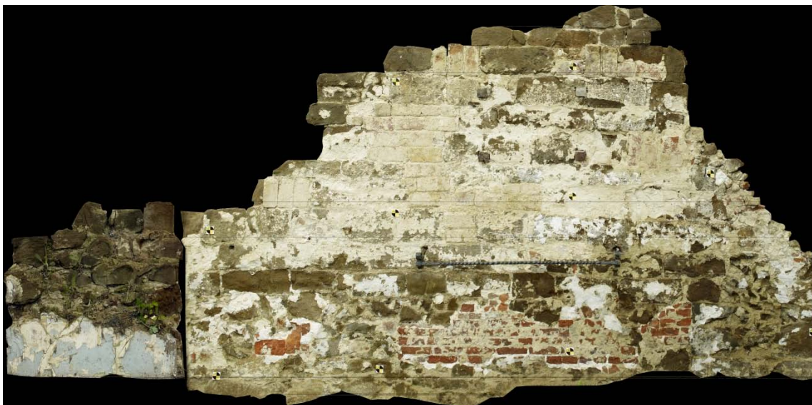
Fig. 3.2: Foto van de binnenmuur van de toren.
