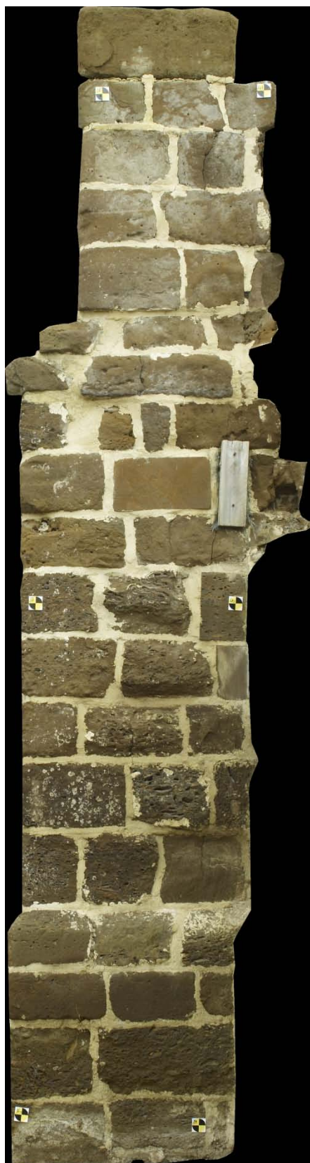
Fig. 3.5: Foto van de muur vanuit het schip van de kerk.
