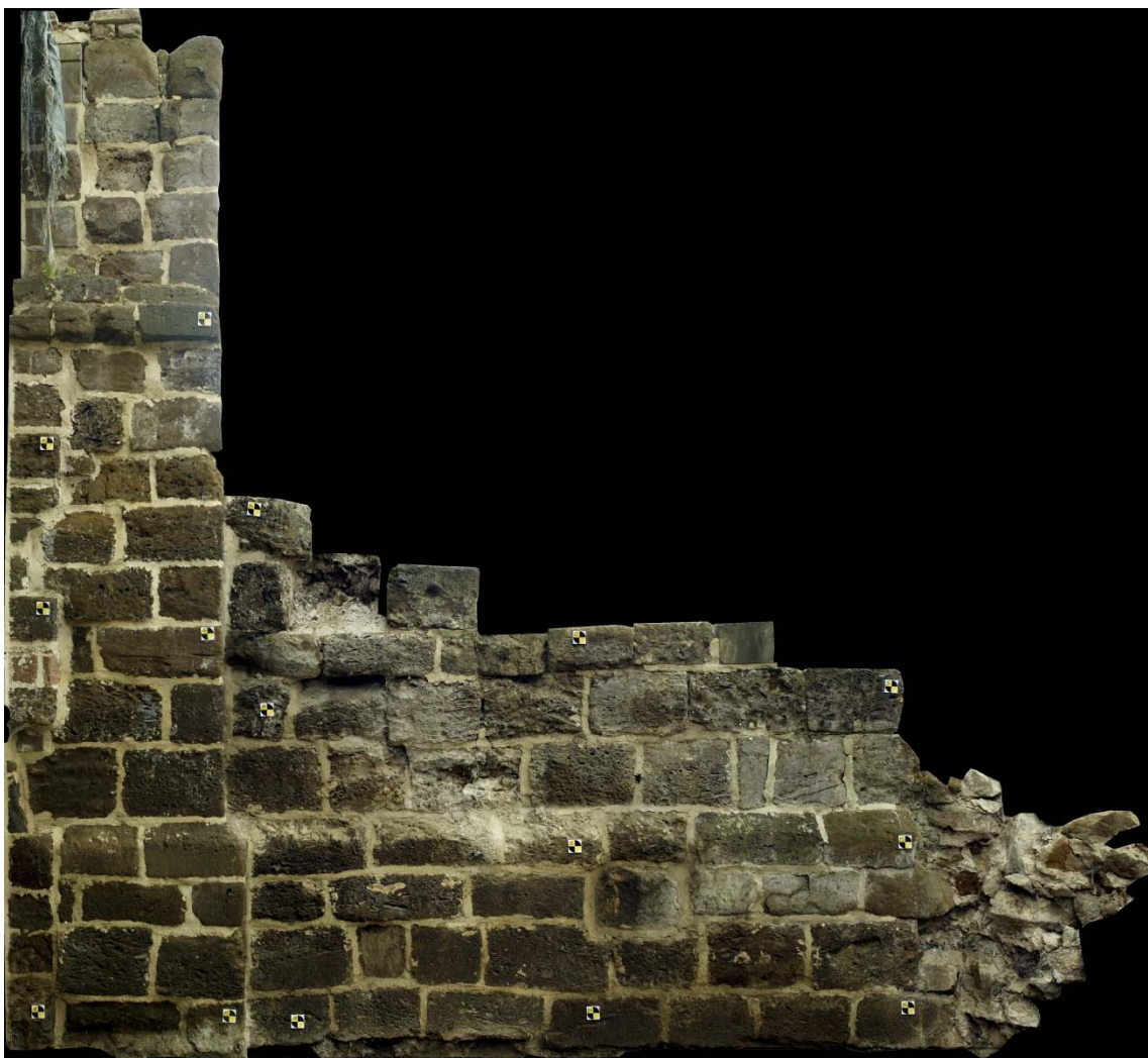
Fig. 3.3: Foto van de buitenmuur van de toren.
