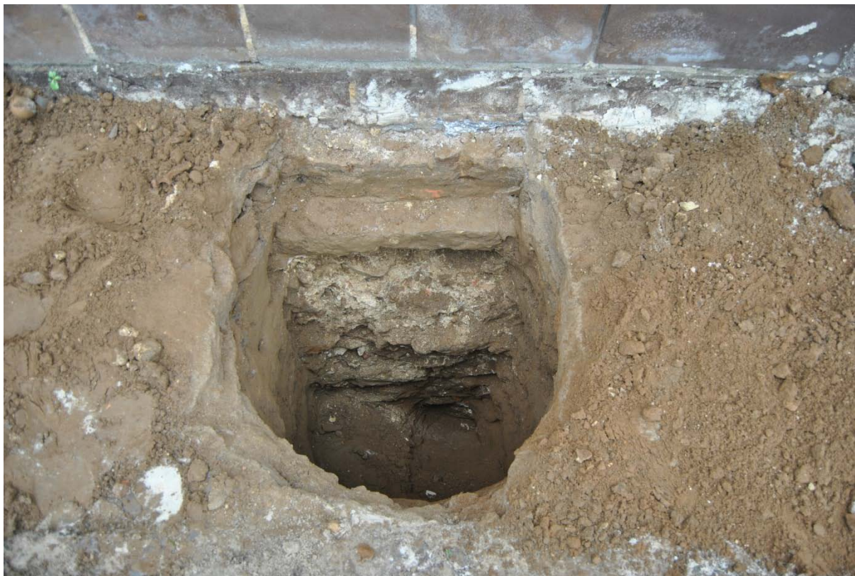
Fig. 3.11: Controleput tegen de zuidelijke muur van de dwarsbeuk.
