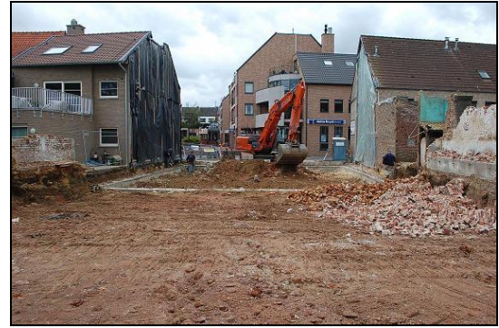
Fig. 6: Het weghalen van het afbraakpuin.
