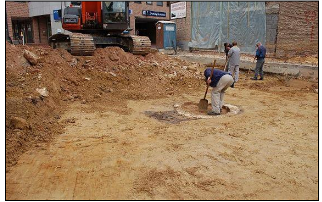
Fig. 11: Het afschaven van de werkput na het verwijderen van het afbraakpuin.
