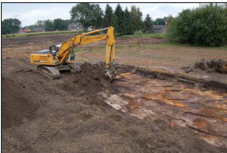
Fig. 8: Zicht op de aanleg van de wegwaffer na het ontbossen van het terrein. (Bron: ARON bvba)
