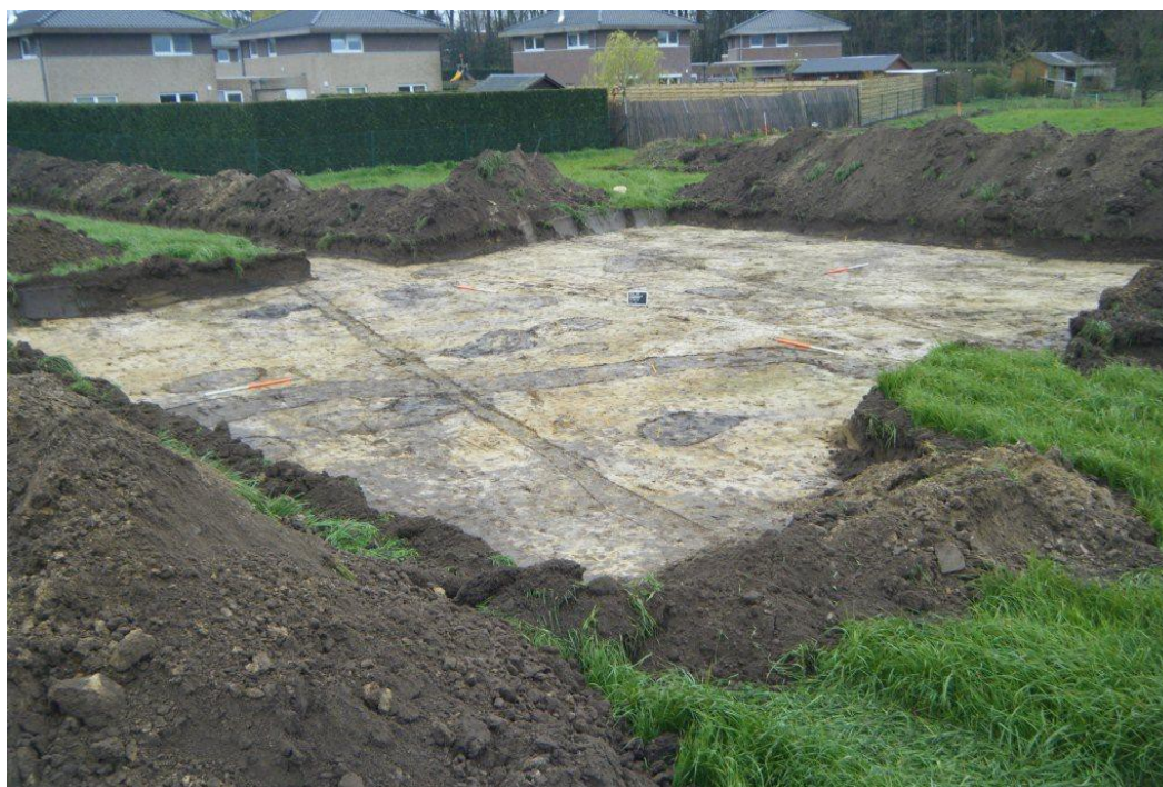
Fig. 42: Kijkvenster in WP2
