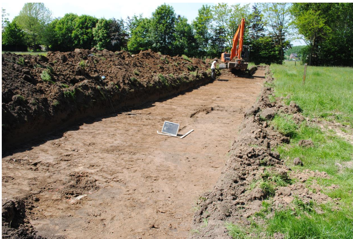
Fig. 2.2: Aanleg van het vlak.
