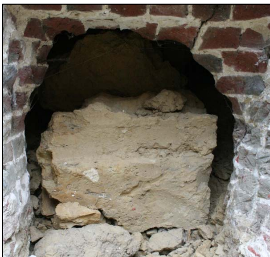
Figuur 47 : Verplaatste moederbodem met kalk, houtskool- en baksteenfragmenten
