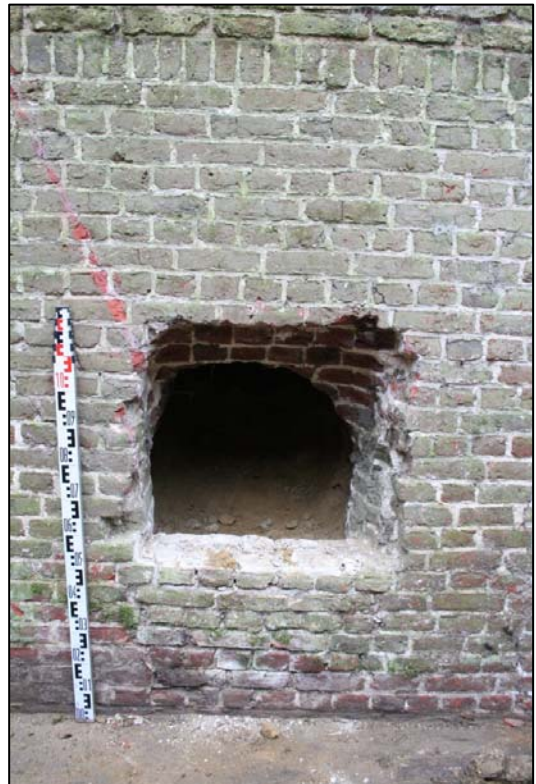
Figuur 46 : Opening in de westelijke muur van de maalterij
