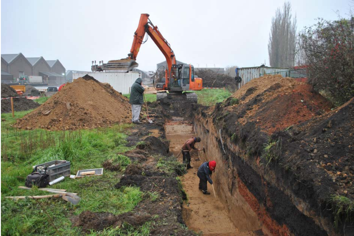
Fig. 2.1: De aanleg van de sleuf.
