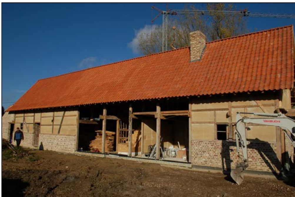
FIG. 1 De restauratiewerken aan de hoeve.
