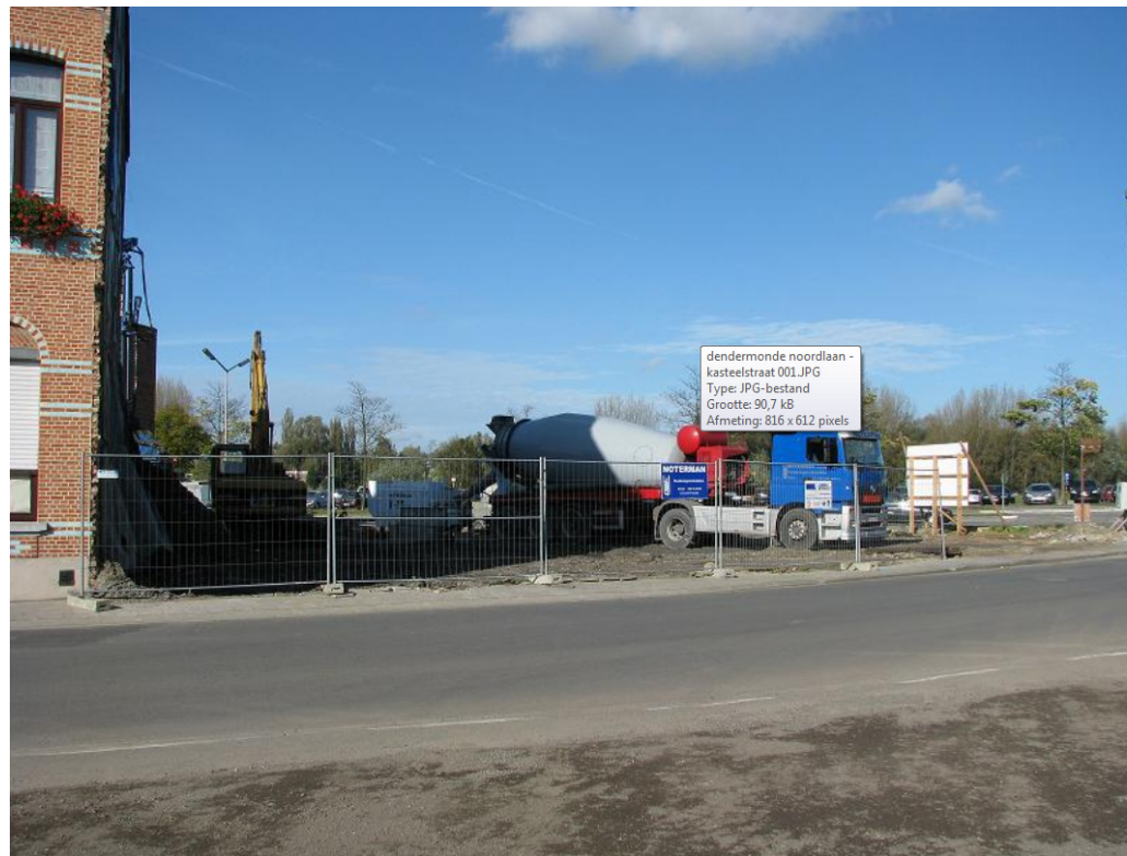
Afb 4: Hoek Noordlaan - Kasteelstraat na afbraak van het huizenblok.
