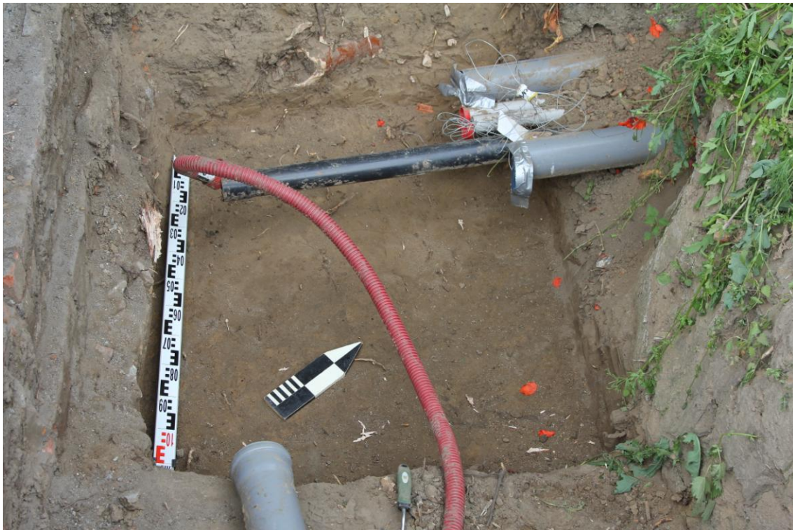
Fig. 125: Noordelijk deel van het grondvlak van werkput 5.
