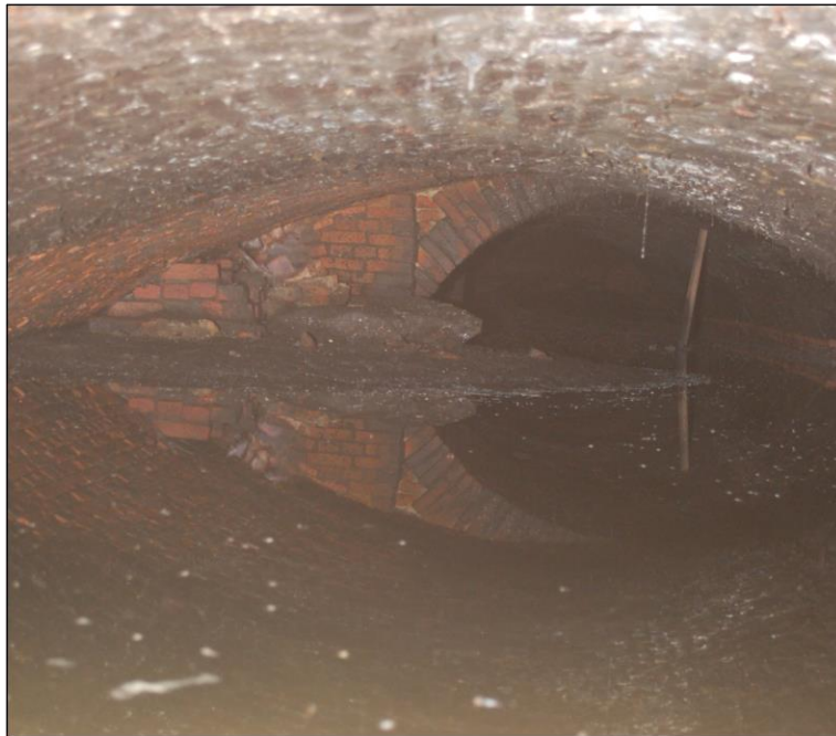
Fig. 24 De overdekte Minnevliet aan de binnenzijde.
