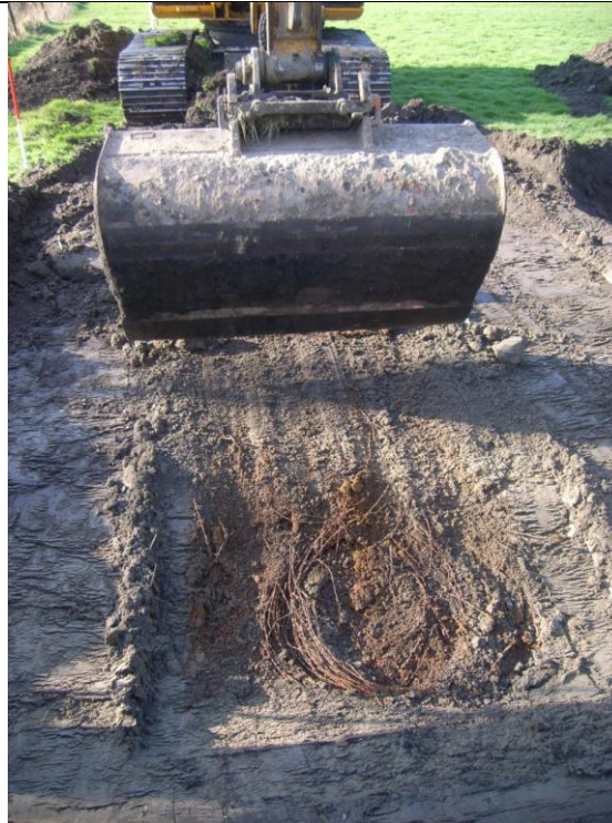
Fig. 5: Prikkelendraad en bouwpuin in de ploeglaag
