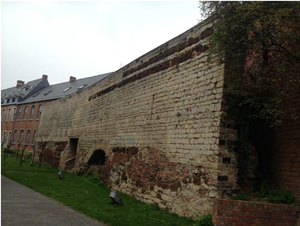
Fig. 2.28: Zicht op een bewaard stuk van de eerste stadsmuur (veldzijde), met op de achtergrond het lers College. De aarden wal die tegen de voet van de muur lag, is verdwenen, waardoor de spaarboog van de funderingen vrij ligt.
