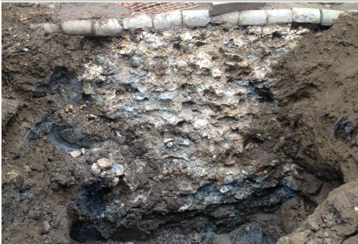
Fig. 4.10: Zicht op een deel van de 'gecoupeerde' poortfundering.
