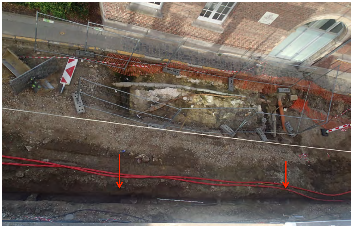
Fig. 3.6: Onderaan bevindt zich de smalle sleuf van de omgelegde nutsleidingen. De twee pijlen geven het begin en einde van het fundament aan.
