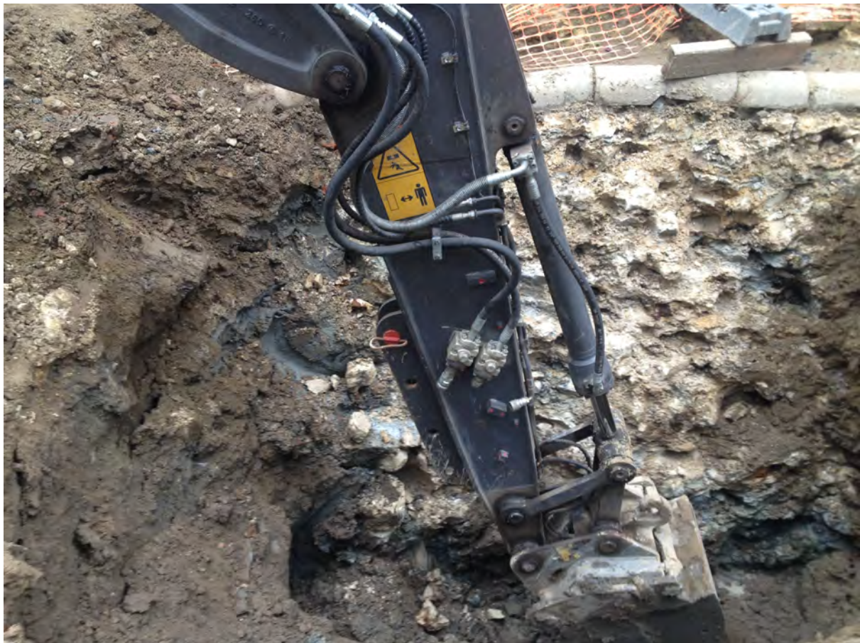
Fig. 3.7: Machinaal wegbreken van de murresten.
