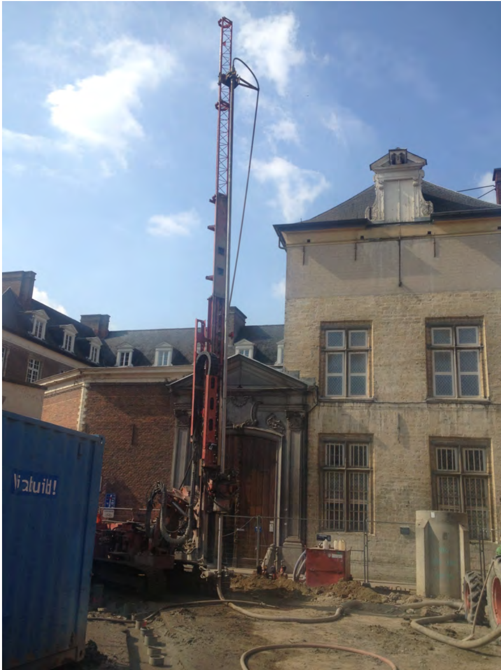
Fig. 3.8:Plaatsen van de groutpalen ter hoogte van het Damiaanplein.
