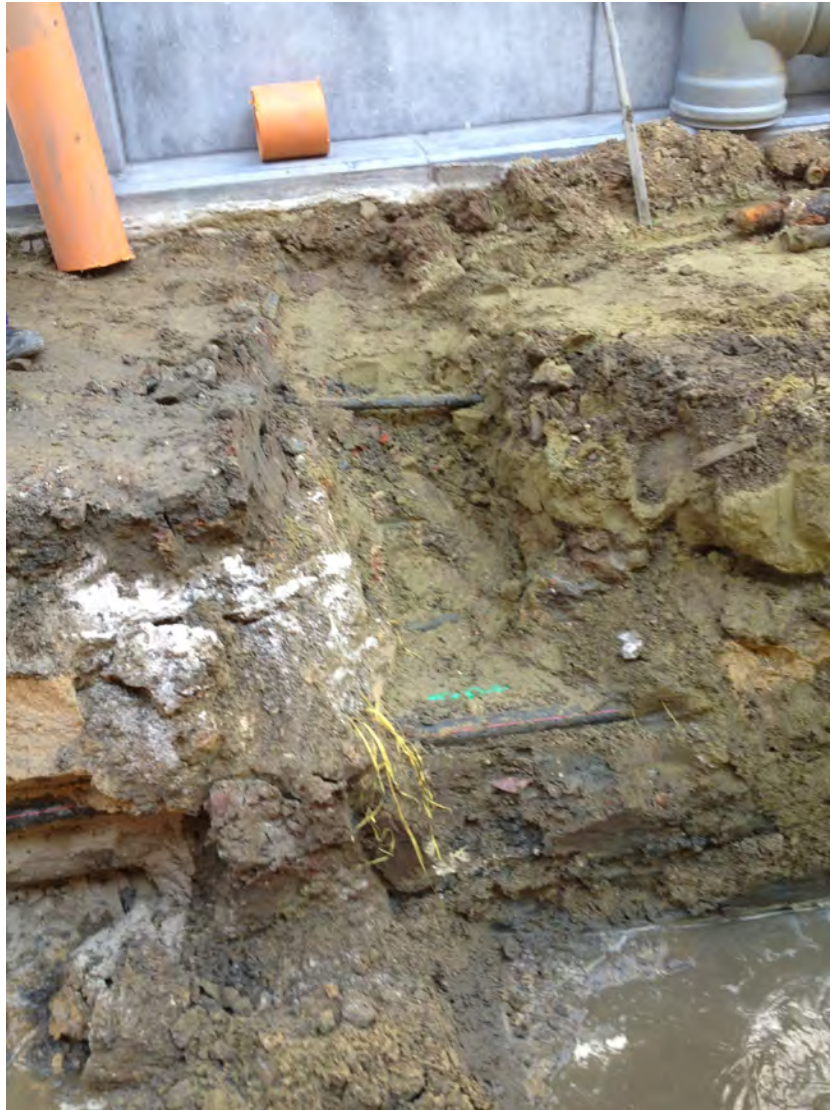
Fig. 3.2: Zicht op de aanwezige nutsleidingen na uitbreken van de huidige riolering (kant Paridaens).
