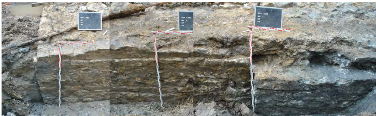
Fig. 4.4: Compilatiezicht op de zijkant van S1. Omwille van aanwezige leidingen kon niet over de volledige lengte van de poort gegraven worden. De onder kant van de fundering is niet zichtbaar op deze foto.
