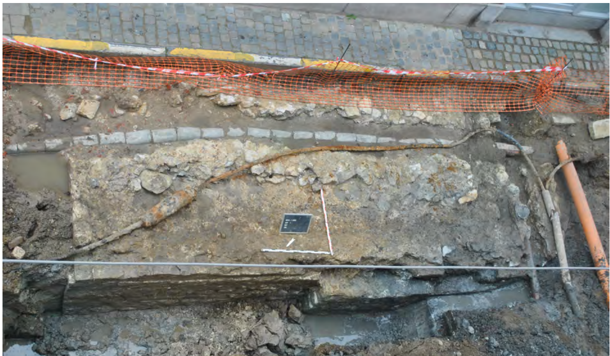
Fig. 4.9: Bovenaanzicht van de fundering van de stadspoort met duidelijk zichtbaar de verspringing.
