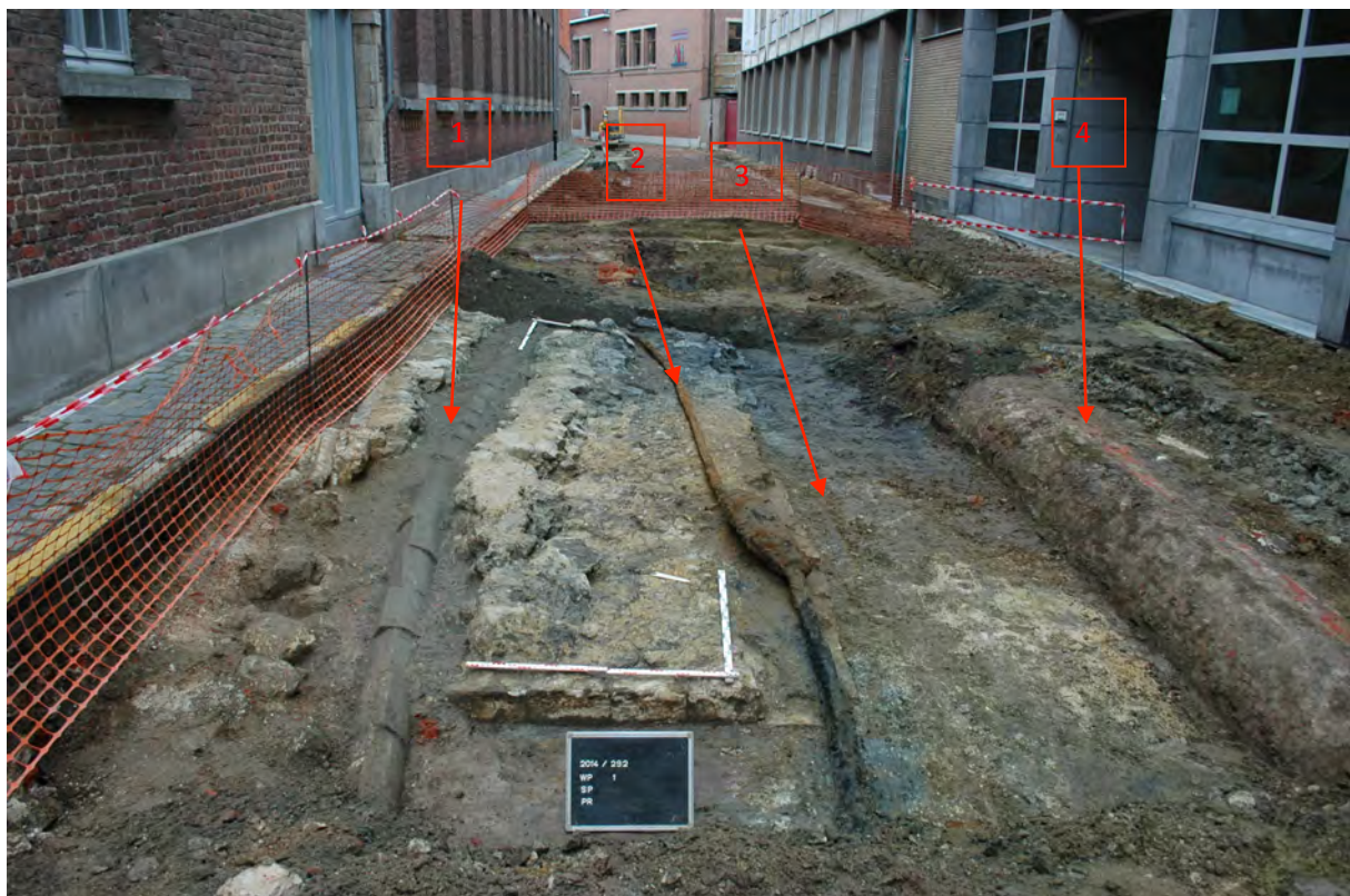
Fig. 3.1: Vrijgelegde delen van de Broekstraatpoort op 19 augustus 2014. 1=datakabel, 2=middenspanningkabel, 3=waterleiding, 4=huidige riolering.
