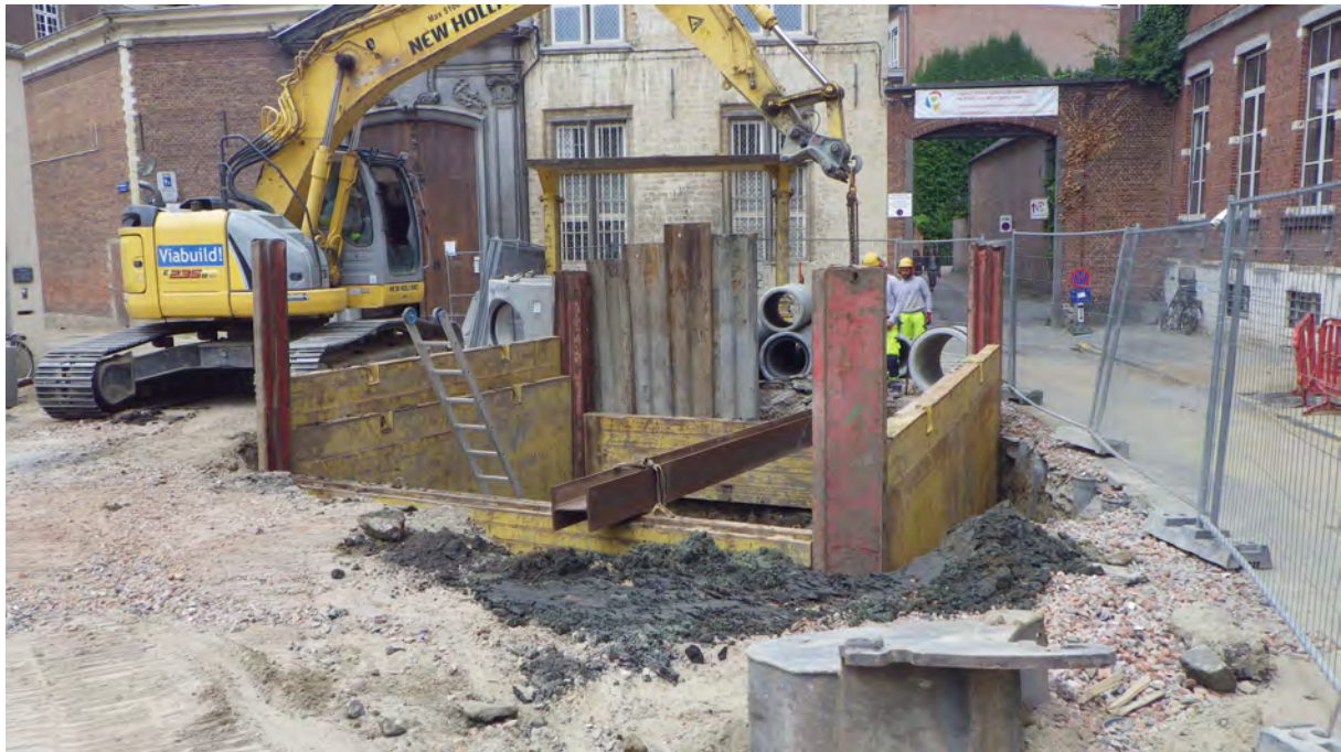
Fig. 3.9: De beschoeide bouwput op het Damiaanplein.
