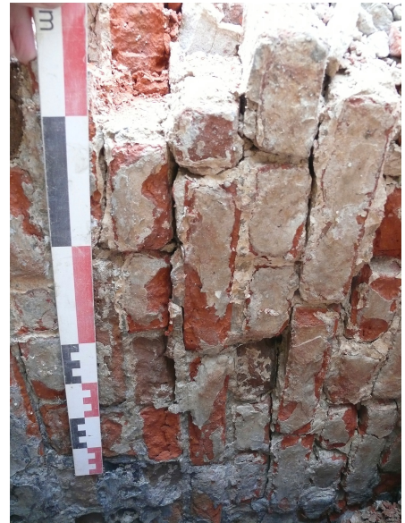
Fig. 29 Zicht op het metselwerk van het gewelf met kalkmortel in de voegen en kalkbeschildering op de binnenzijde.
