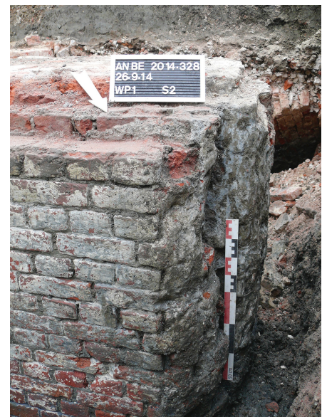
Fig. 25 Afgeknot muuruiteinde met zicht op de bouwnaad van de gevel in het verlengde van de maatlat.
