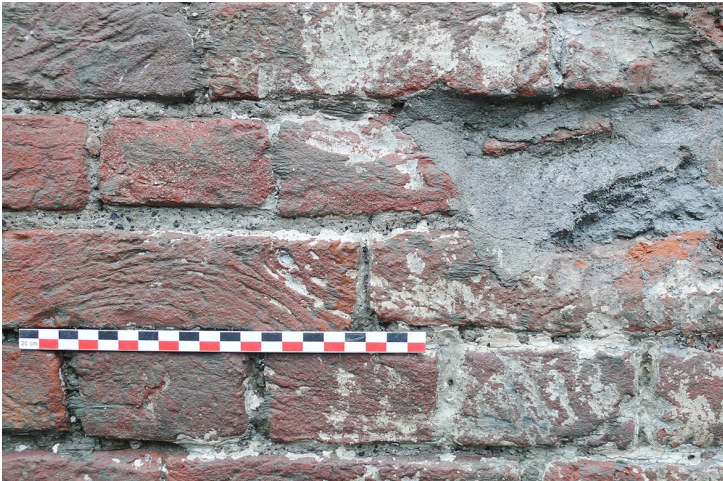
Fig. 33 Detail van het muurwerk van de gevel (parement) gemetst met grijze kalkmortel waaraan een zwart glasachtig puzzolaan werd toegevoegd. Het muuroppervlak draagt sporen van witte kalkbeschildering en een holte werd bij een herstelling opgevuld met cementmortel.
