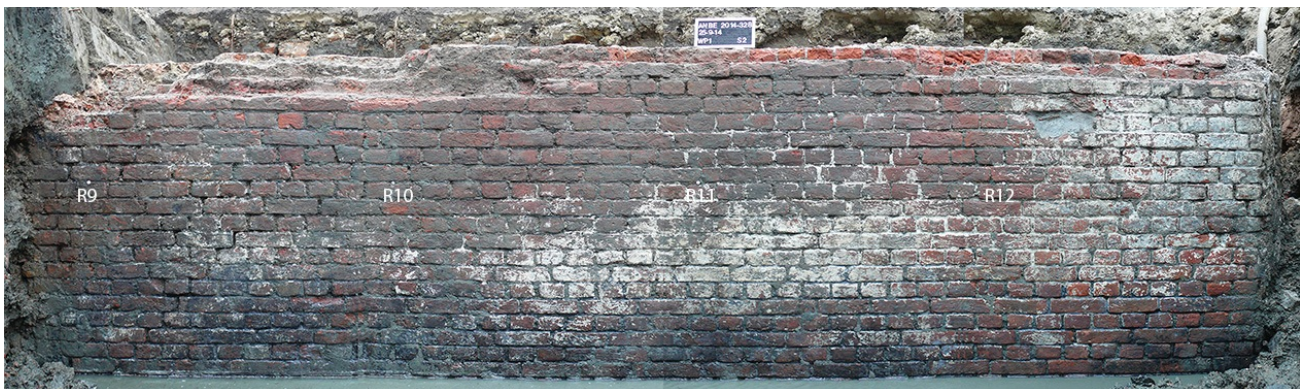
Fig. 26 Fotocompilatie van het metselwerk van het opgaand muurwerk van de noordoostgevel en met aanduiding van de referentiepunten R9 tot R12.
