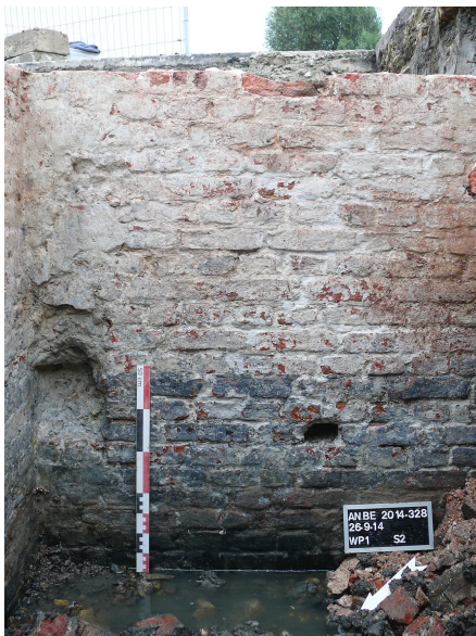
Fig. 24 Zicht op de binnenmuur met de positie van mogelijke stellinggaten.
