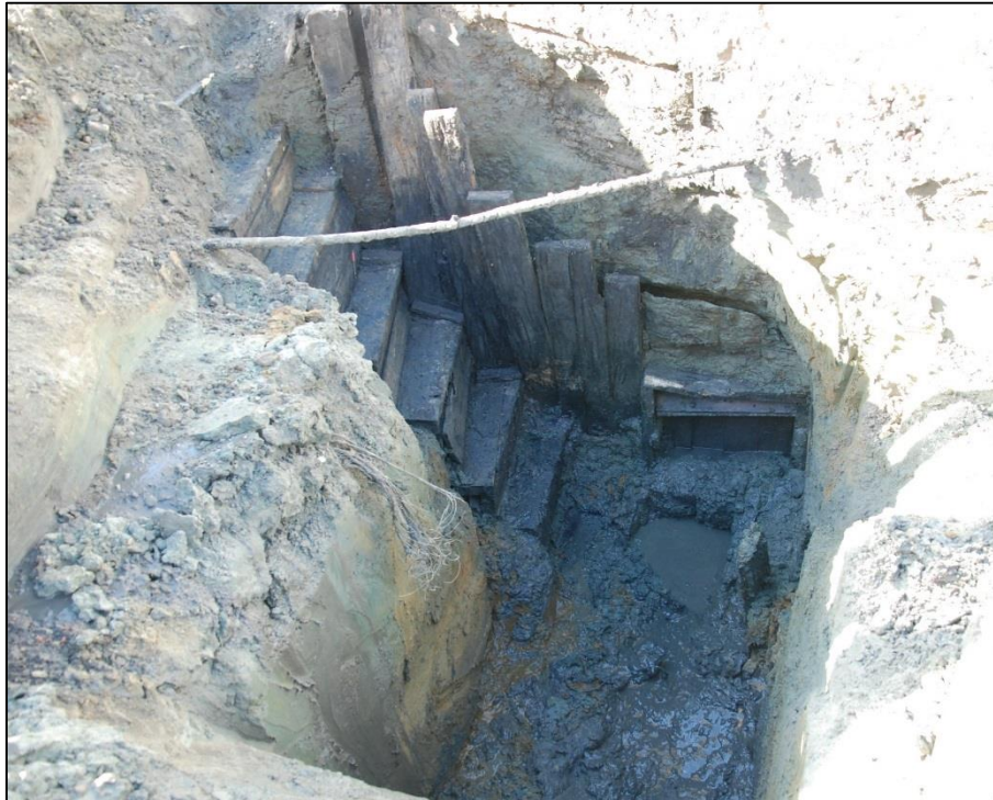
Fig. 7 De toegangstrap is zeer steil met hoge treden. Onderaan rechts is al de bovenkant van de aanzet van een overloop(?) te zien. Werd de ondergrond te moeilijk om te beheersen?
