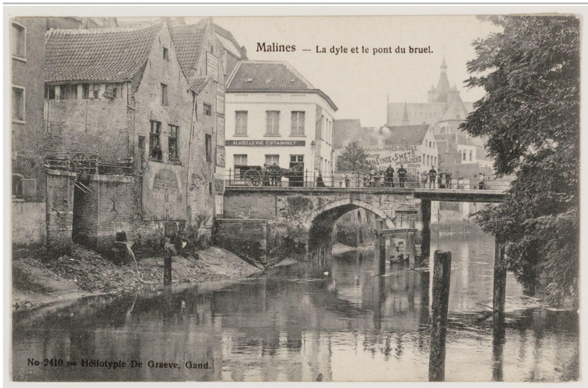
Fig. 1.20: Zicht op de brug over de Dijle met links het platform waar de fontein op stond 20 .
