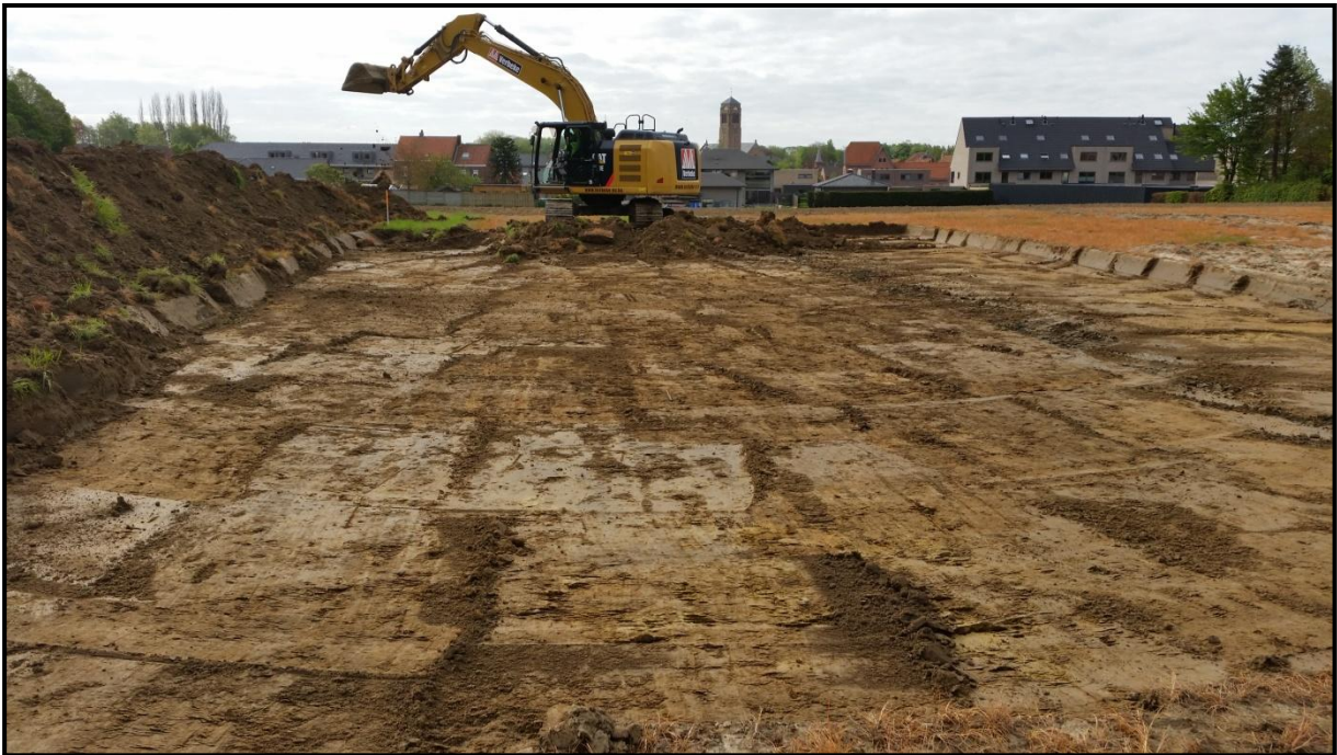
Figuur 28: Machinale afgraving van de teelaarde (1 ste fase) met aparte stockering.
