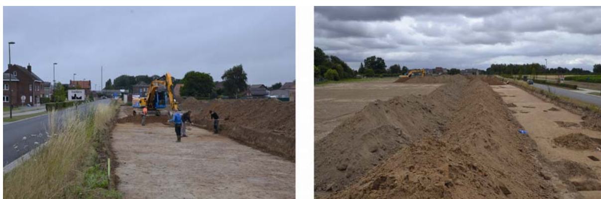
Fig. 1.2. Geetbets-IJzerwegstraat. De machinale aanleg van een werkput langs de IJzerwegstraat (links) en een overzicht van het onderzoeksterrein (rechts).
