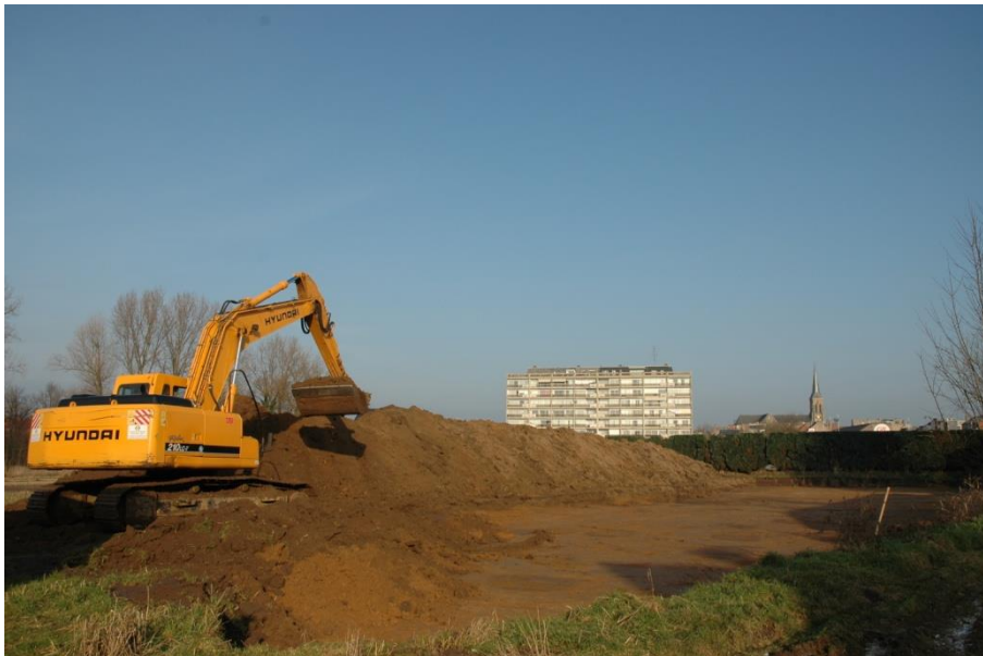
Fig. 4: Machinaal afgraven van werkput 1.
