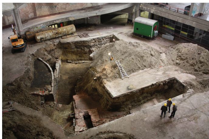
Fig. 3: Het opgravingsvlak met in het noorden de middeleeuwse elementen en in het zuiden de restanten van de industriële fase (Stad Gent, De Zwarte Doos, Stadsarcheologie Gent).
