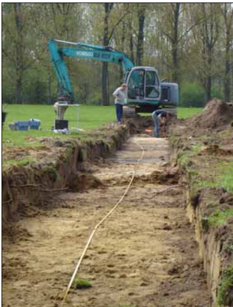
Figuur 19. Impressie van de aanleg van de proefsleuven.
